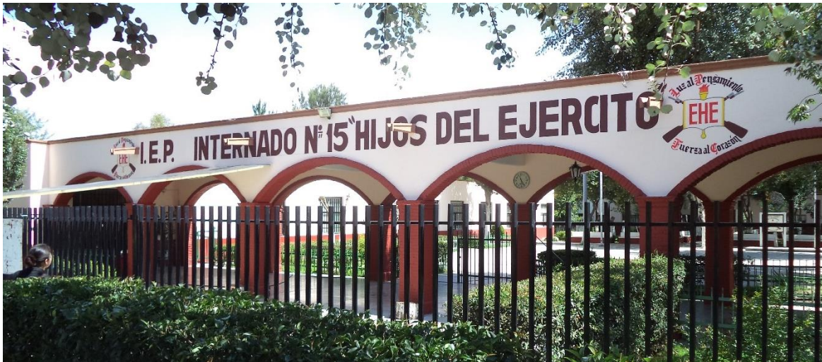
Imagen 20. Fachada de EIHE No. 15 en Pachuca, Hidalgo. Ya no funciona como Internado desde 2015
