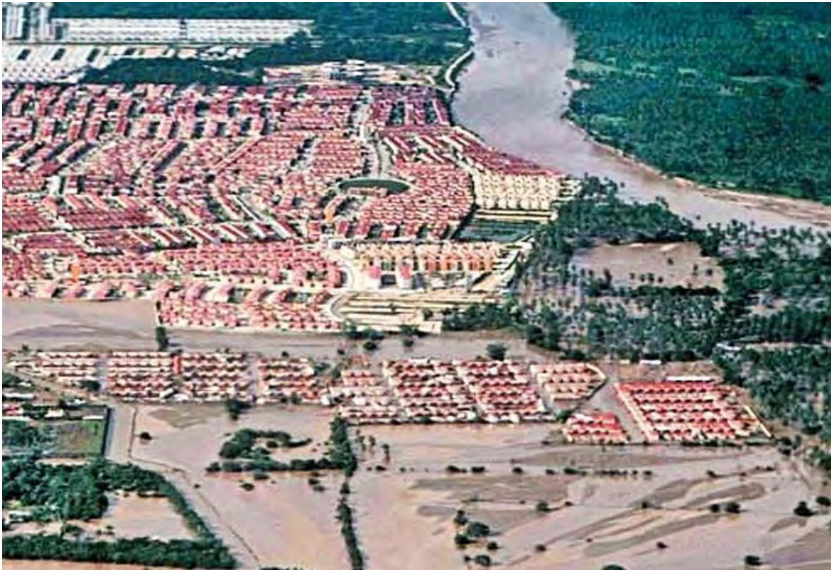
Imagen 8: Zona del principal desbordamiento río La Sabana (lado superior derecho), afectaciones a viviendas (lado izquierdo y centro), al Noreste de la Zona Costera de Acapulco, 13 de septiembre del 2013.
