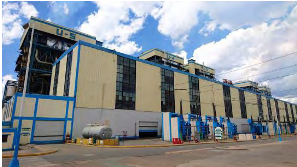
Figura 3.6. Unidades de generación de la CTFPR
