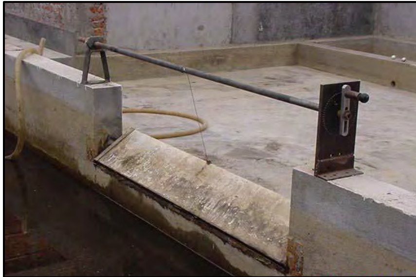
Figura 3.4. Compuerta de tipo abatible
