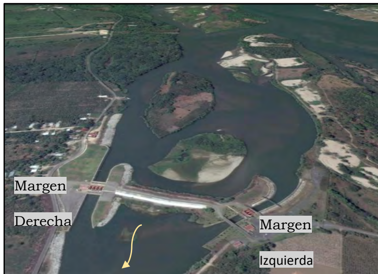
Figura 1.2. Estructura de Control “El Macayo”
