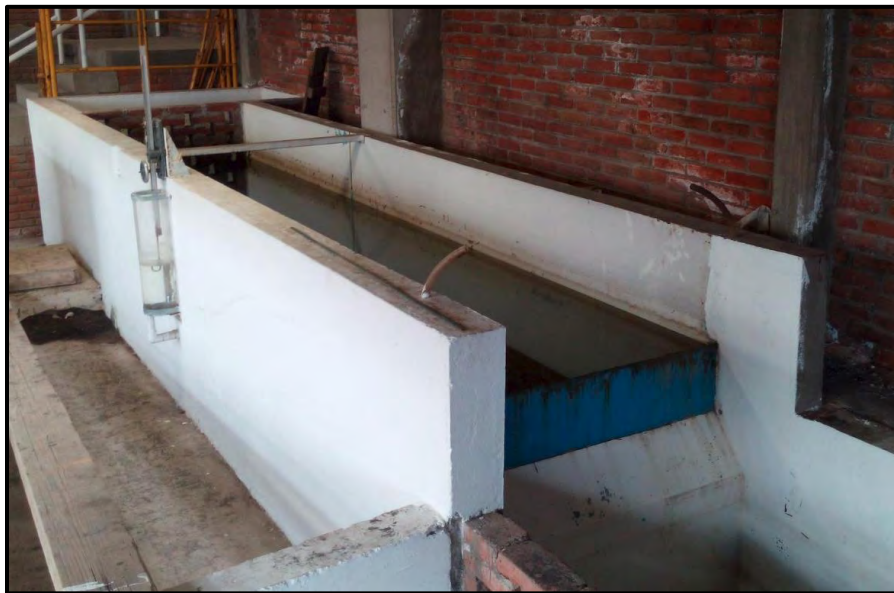
Figura 3.2. Canal de acceso, vertedor y limnómetro para aforo
