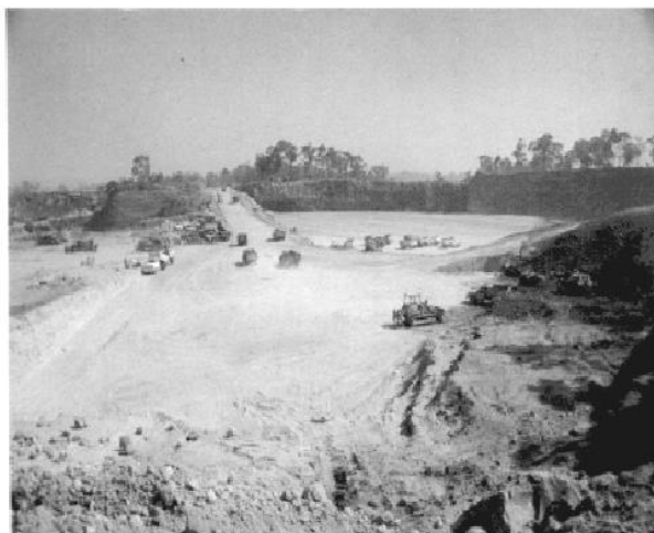
Construcción del Relleno Sanitario Prados de la Montaña
