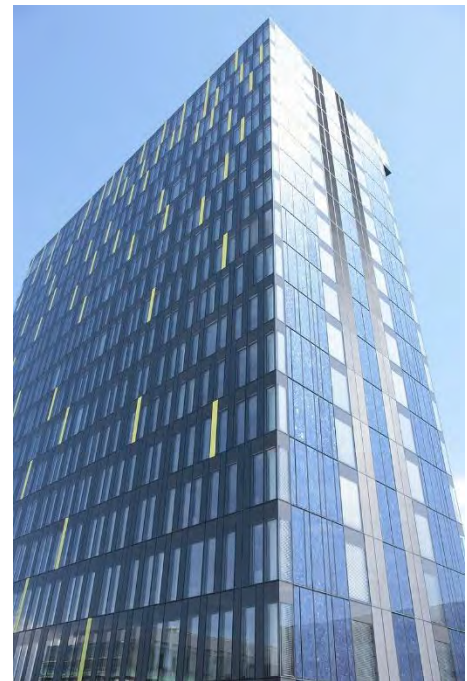
Imagen 29. Fachada de la Power Tower, edificio eficiente en la ciudad de Linz, Austria. La cara sur del edificio está equipada con paneles solares fotovoltaicos integrados en la fachada. https://es.wikipedia.org/wiki/Arquitectura_sustentable . Mexico 2017.
