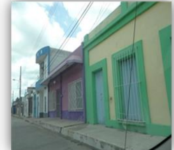
Vivienda en zona centro un nivel
