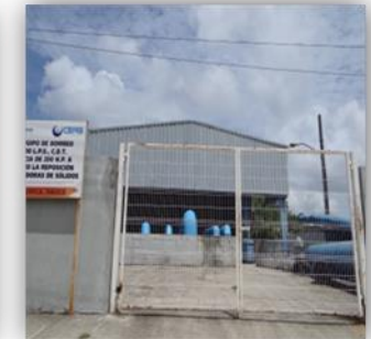
Planta de bombeo de agua
