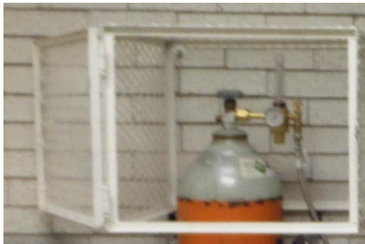
Imagen 6. Reja de protección del tanque
