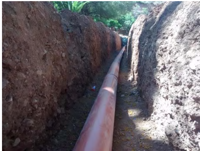
Figura 5 Línea de agua potable 8
