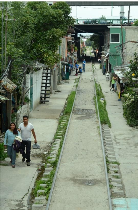
Fotografía propia en la cual puede observarse el trazo de vía, al fondo un puente vehicular y sobre este el tramo elevado de periférico. También es posible observar asentamientos irregulares construidos a lo largo del tramo de vía. 2015.
