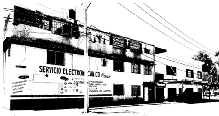
Fotografía II.- Superficie libre inexistente Fuente: propia
