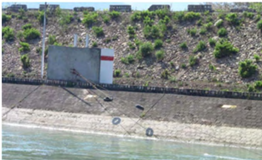
Figura 2.7 Ejemplo de anclaje de peso muerto
