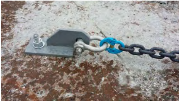
Figura 2.10 Ejemplo de anclaje de empotramiento
