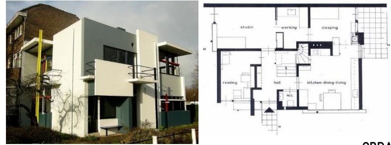
CASA SCHRÖDER, EN UTRECH, PAISES BAJOS, 1924
