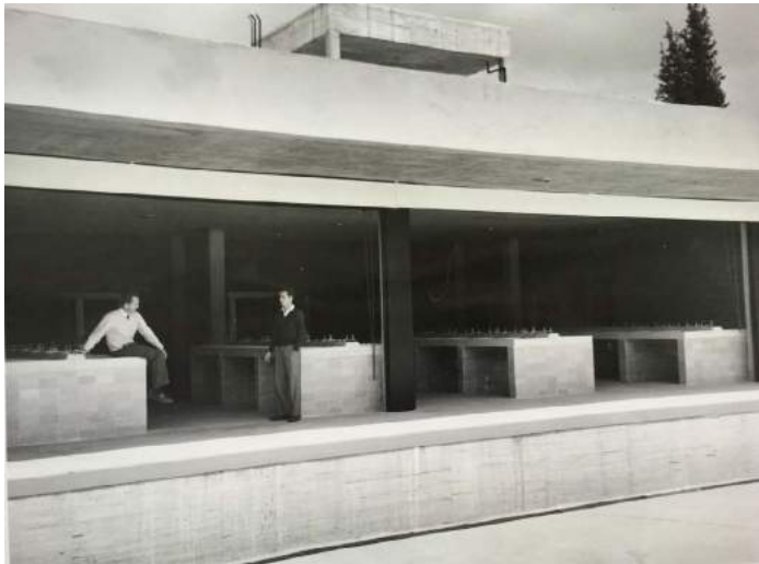
Imagen 32. Vista de las mesas de preparación de mercancía. Archivo fotográfico mercado de Coyoacán, Fondo APRM.
