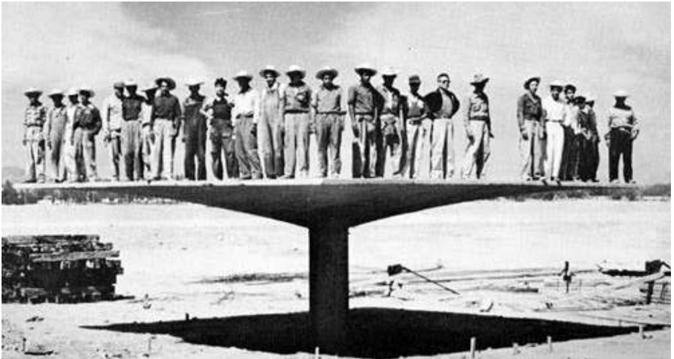
Imagen 19. Prototipo de paraguas invertido realizado en obra en Pedro Ramírez Vázquez: imagen y obra escogida, México, UNAM, 1988.
