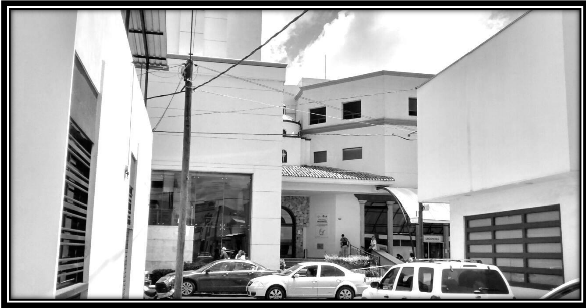
Imagen 3.7.- Fotografía de la fachada del hospital tomada en dirección al Este.
