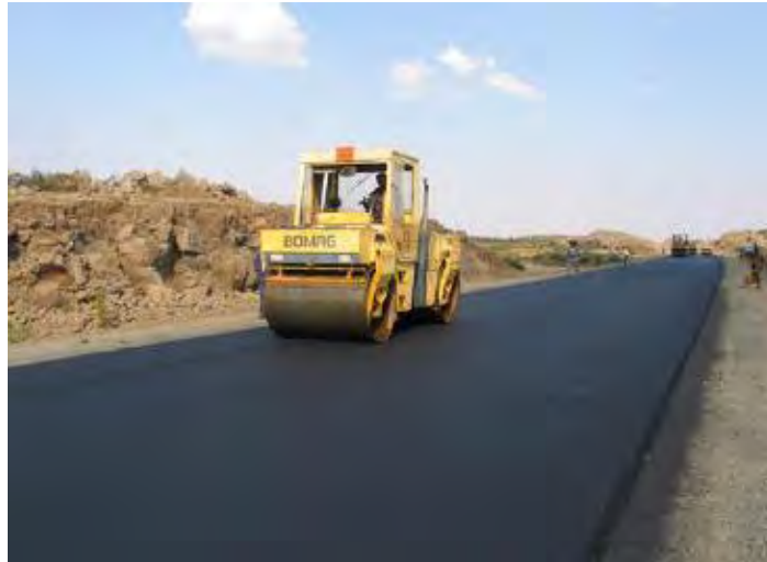
Fig. 2-13 Compactación de una mezcla asfáltica densa (Rangel Galicia, 2015)
