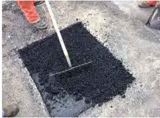
Fig. 2-16 Reparación de baches (Rangel Galicia, 2015)
