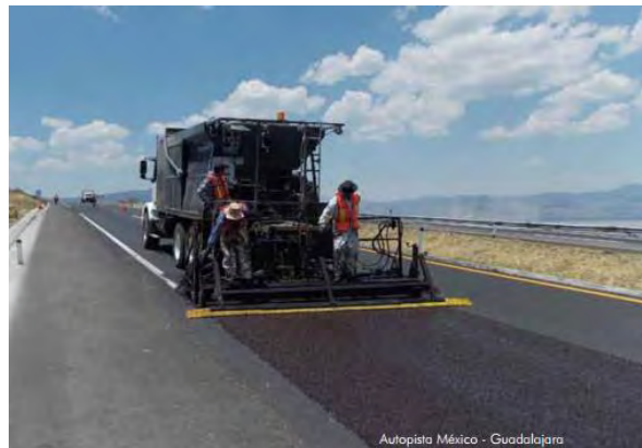
Fig. 2-17 Colocación de mortero asfaltico (ALTEA, 2014)
