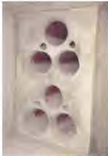
Fig. 2.19 Ductos en configuración delta
