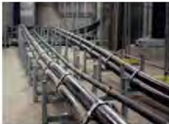
Fig. 2.9 Sistema de instalación rígido
