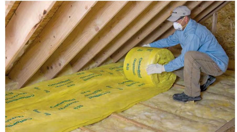
*Detalles de instalación de lana de vidrio como material acústico en pisos, muros, azoteas y plafones*
