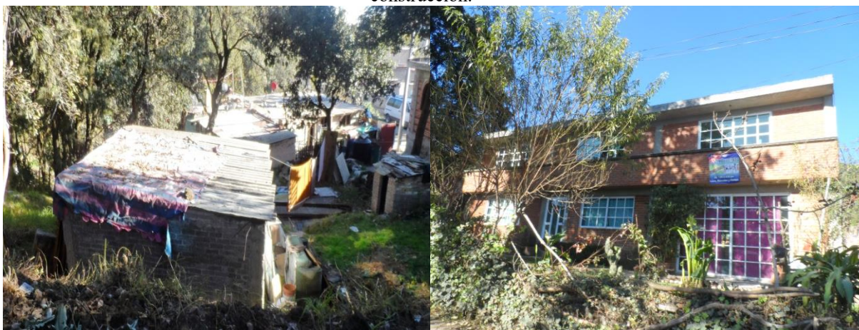
Vivienda con techo de material no duradero
