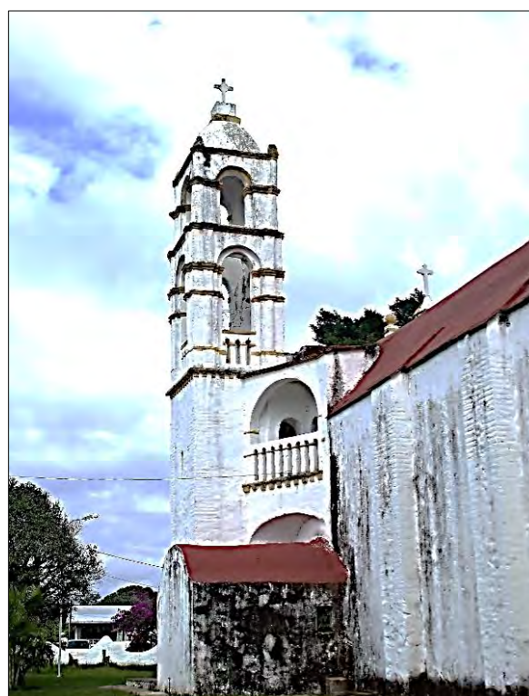
Figura 3.18. Detalle exterior del templo (lado sur)
