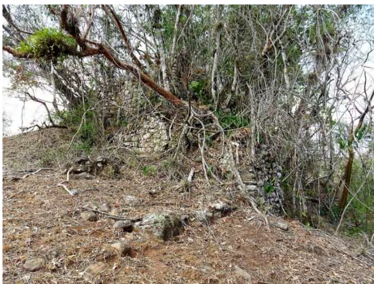
Figura 5. 5. El Castillo, muralla escalonada siglo XIX (litografía de H. Iriarte en Sartorius 1869) y estado actual, destacamos la presencia de cementante y recubierto con estuco
