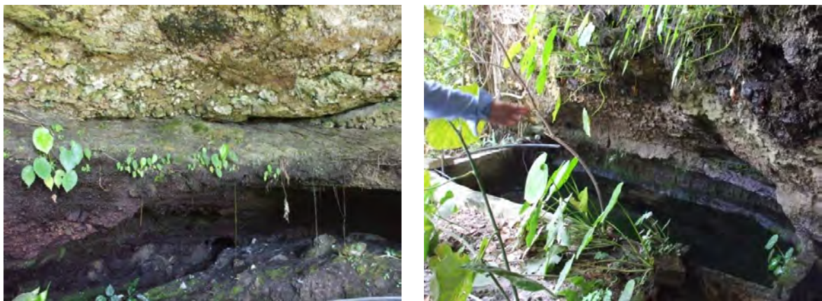
Figura 7.56. Abrigo rocoso con manantial: oquedad y depósito construido
