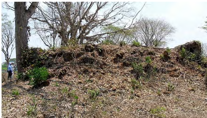
Figura 5.4. Pirámide con dos nichos, estado actual de la construcción
