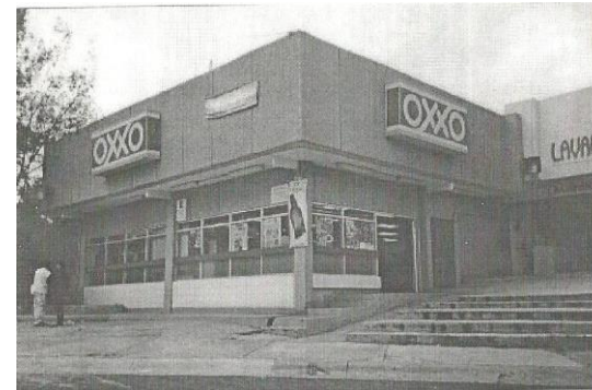
Fachada principal. Foto 23
