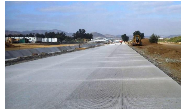
Carpeta asfáltica del Boulevard. Foto 15
