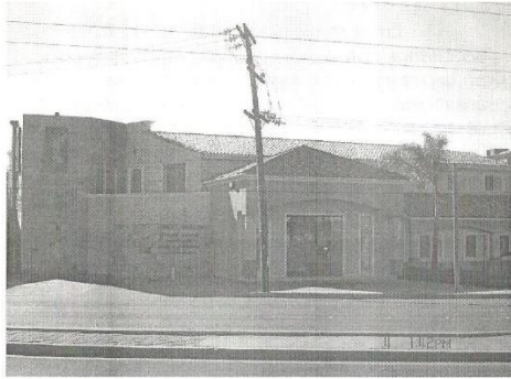
Fachada Principal. Foto 25
