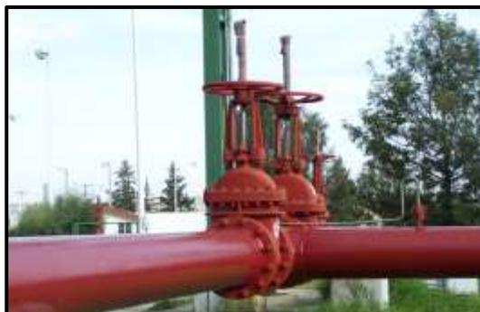
Imagen 7.7. “Válvula de seccionamiento de vástago ascendente”
