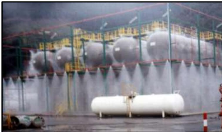
Imagen 5.7. "Sistema de Pulverización de Agua"
