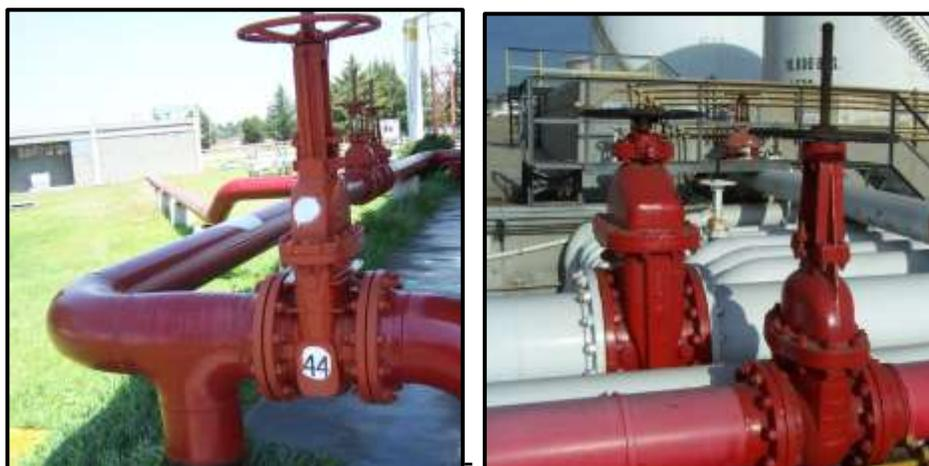
Imagen 7.5. “Válvulas de seccionamiento”
