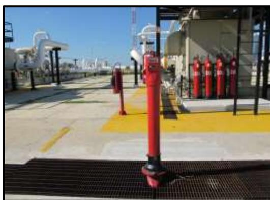
Imagen 7.6. “Válvula de seccionamiento de poste indicador”
