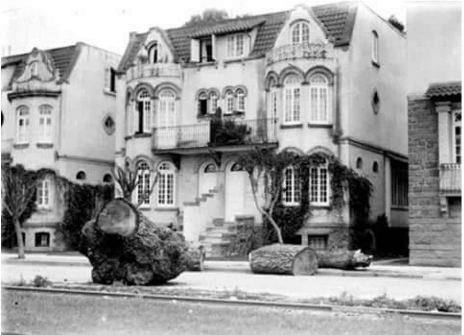
Ilustración 5 Fachada original del Inmueble Catalogado
