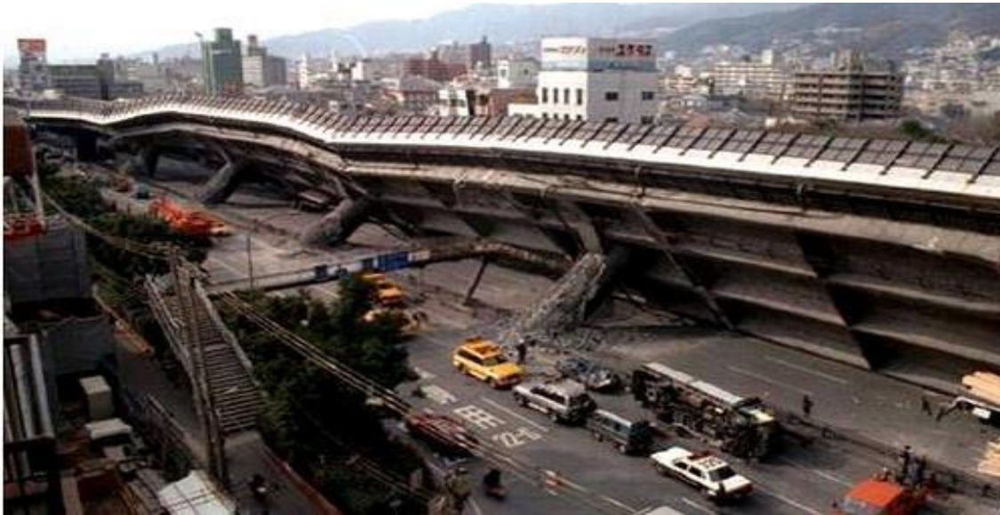
Figura 1.4 Daño en un paso elevado durante el sismo de Kobe en 1995
