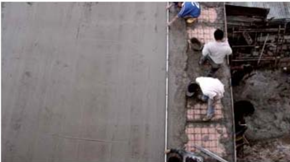
34. Echado de la losa de concreto.
