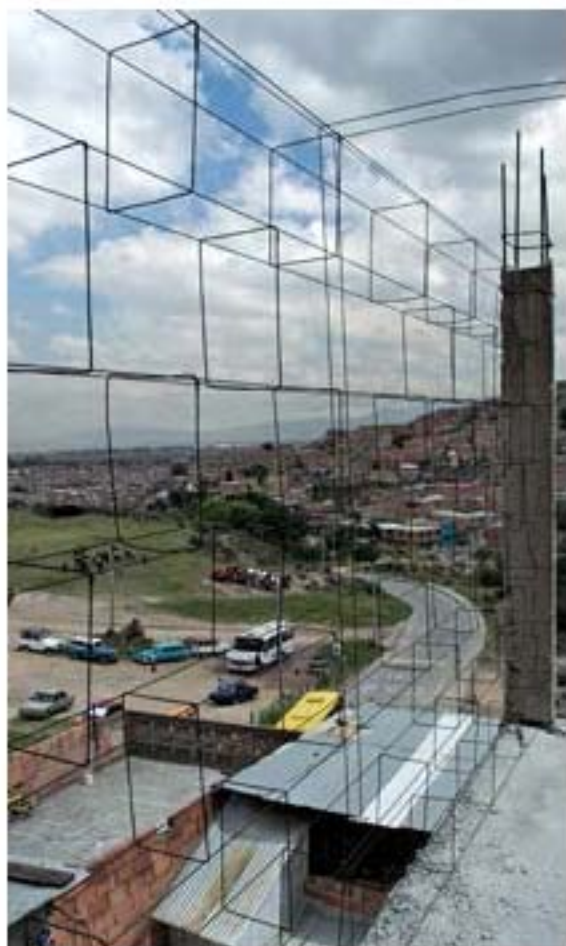
49. Detalle de la estructura de hilo en el segundo nivel de la caseta.
