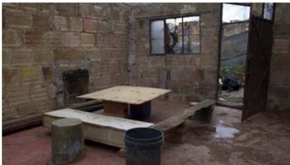
28. Mesa de trabajo improvisada con materiales de obra.
