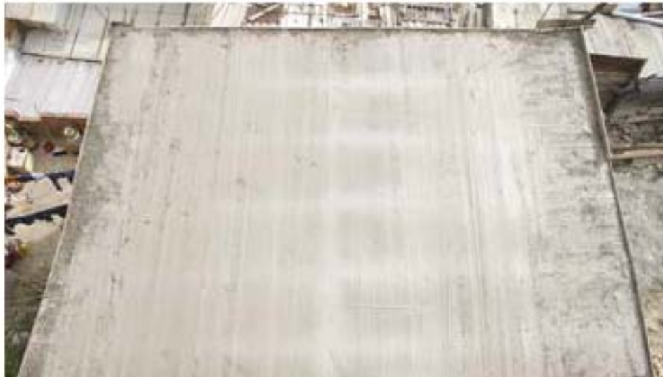
36. Losa de concreto terminada.
