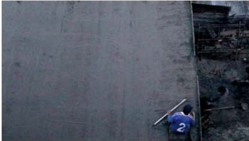
35. Echado de la losa de concreto.
