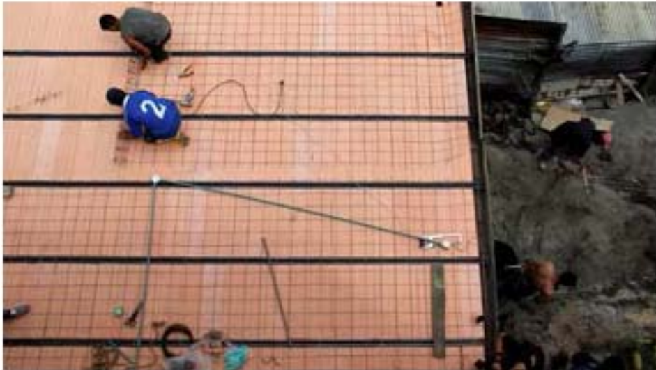
32. Colocación de malla metálica.
