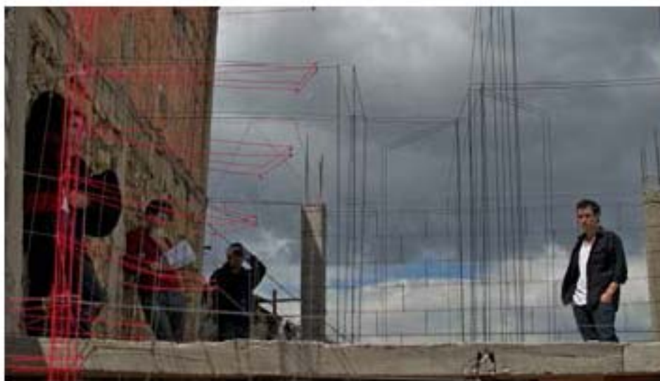
60. Visita a la intervención de hilo en Villagloría
