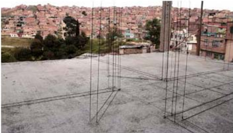
48. Detalle de la estructura de hilo en el segundo nivel de la caseta.
