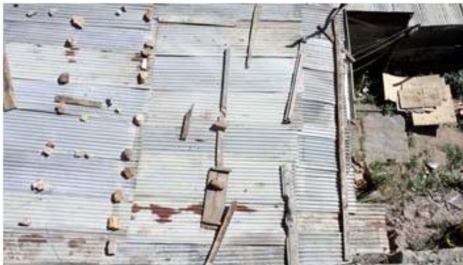
21. Tejado original de lámina de la caseta.
