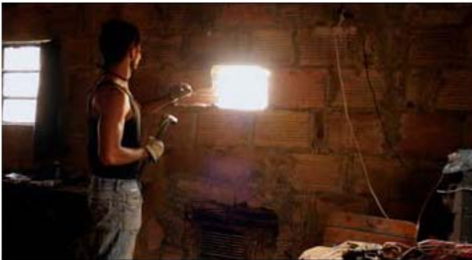
38. Maicol abriendo ventana en la caseta.
