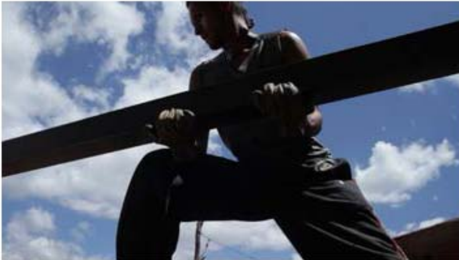
30. Maicol colocando vigas.
