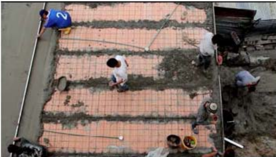
33. Echado de la losa de concreto
