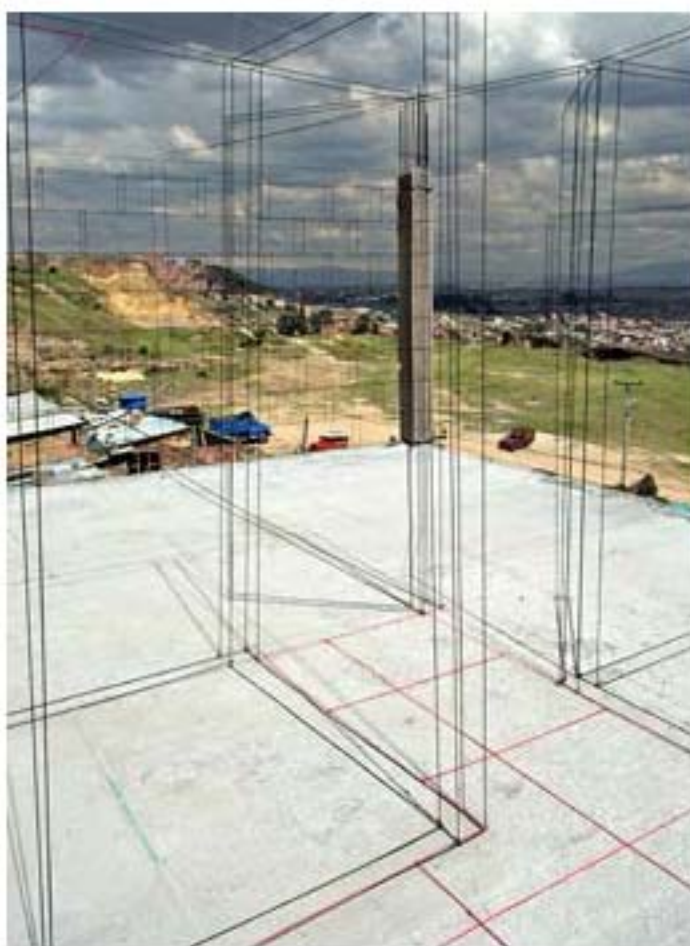
50. Detalle de la estructura de hilo en el segundo nivel de la caseta.
