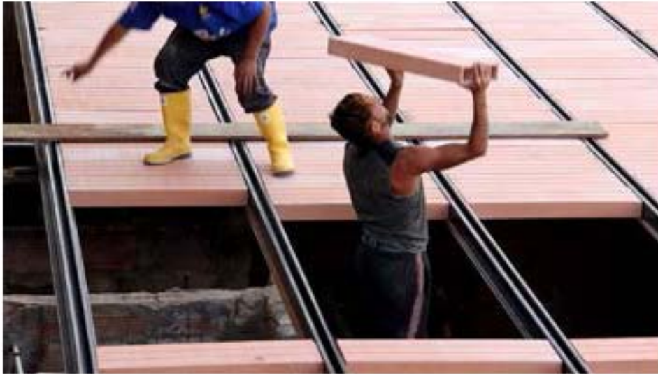
31. Maicol colocando tabique.
