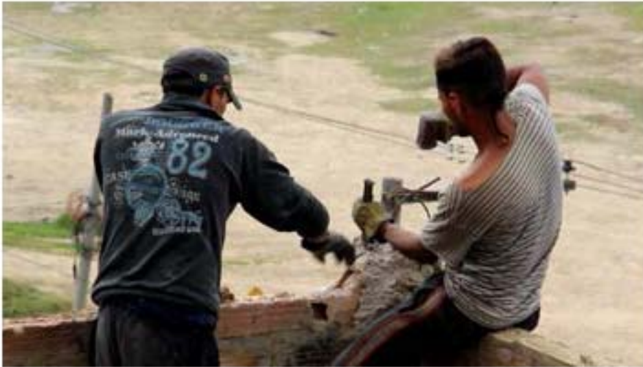
29. Ánghello y Maicol preparando muros para el techado.
