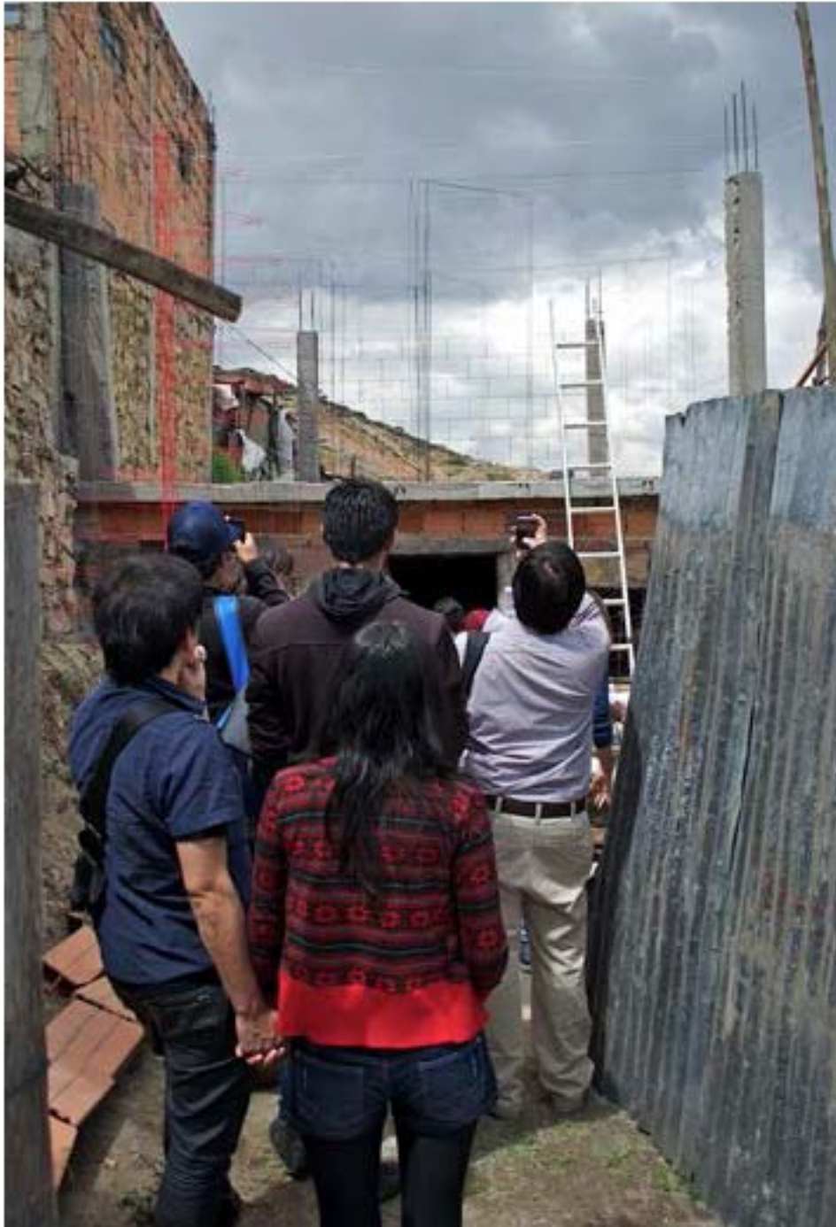
61. Visita a la intervención de hilo en Villagloría
