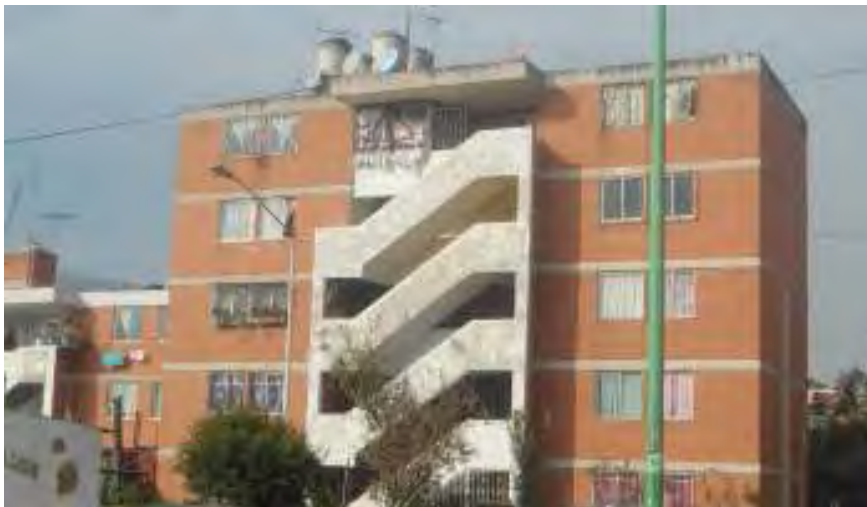
Estado actual de los edificios.
