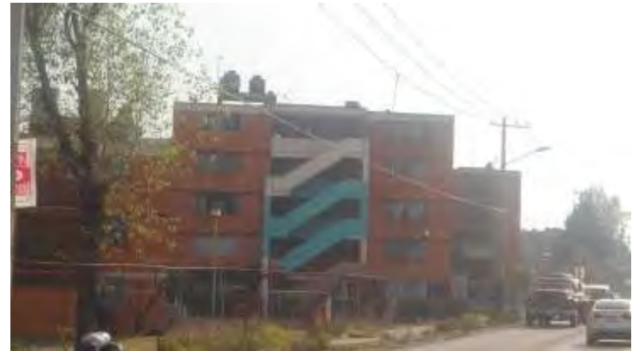
Estado actual de los edificios.
