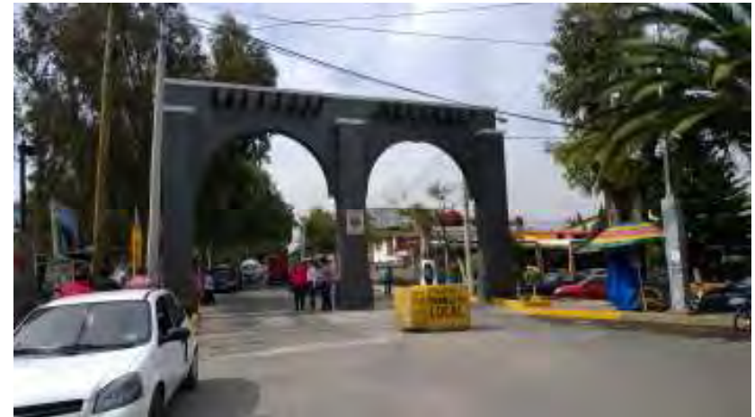
Inauguración de la obra de construcción del Arco del Pueblo de San Lorenzo Río Tenco.
