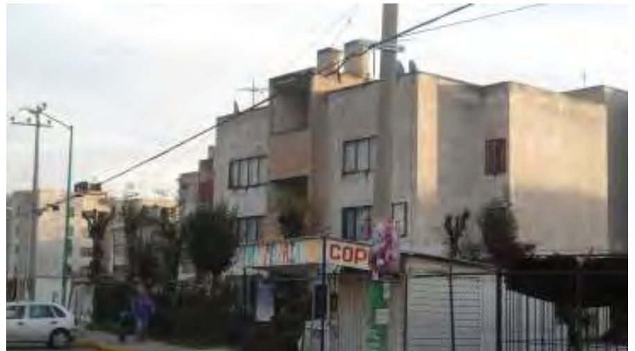
Estado actual de los edificios.
