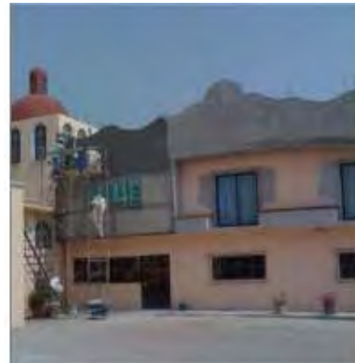
Construcción en la parte posterior de la Iglesia de El Rosario.
