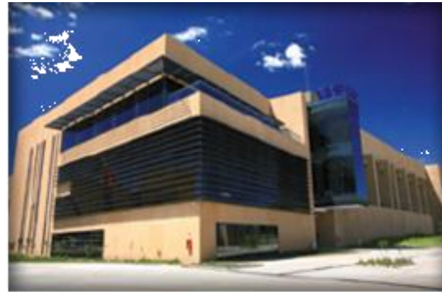
IMAGEN 1. FACHADA DEL MUSEO E IMAGEN 2. FACHADA DEL EDIFICIO ADMINISTRATIVO CENTRO CULTURAL BICENTENARIO COATLINCHAN, ESTADO DE MÉXICO.
