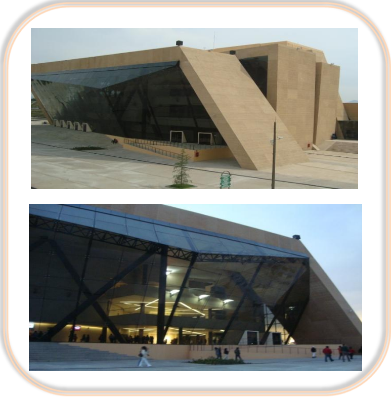
IMAGEN 1 Y 2 FACHADA DEL TEATRO CENTRO CULTURAL BICENTENARIO COATLINCHAN, ESTADO DE MÉXICO.
