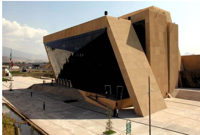
IMAGEN 1 Y 2 CENTRO CULTURAL BICENTENARIO COATLINCHAN ESTADO DE MÉXICO.
