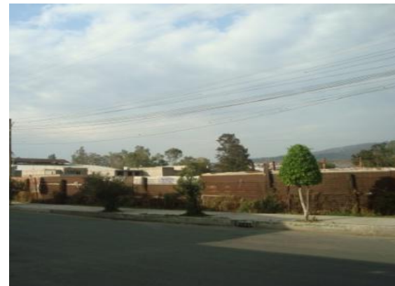
FOTO 7. ACCESO NORTE POR CALLE 2DA CERRADA PINO SUÁREZ
