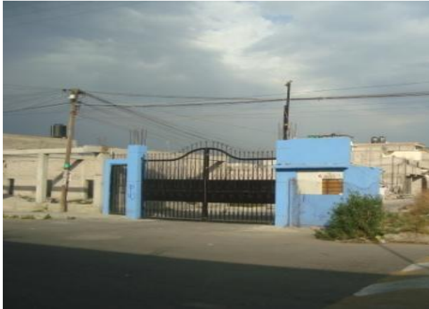
FOTO 8. ACCESO NORTE POR CALLE 2DA CERRADA PINO SUÁREZ
