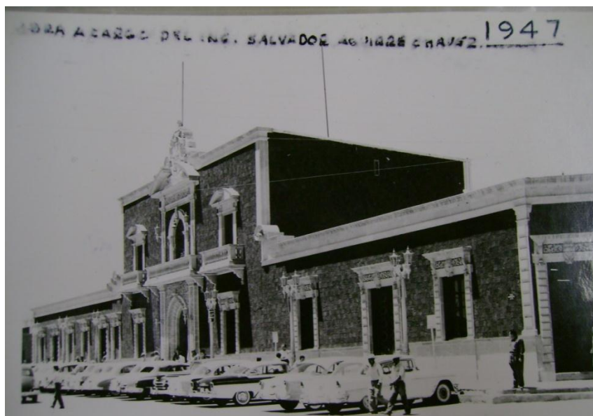
Edificios remodelados y nuevos junto al uso del automóvil dejaron entrever los cambios en la ciudad Biblioteca Central de la UACJ/ Colecciones especiales
