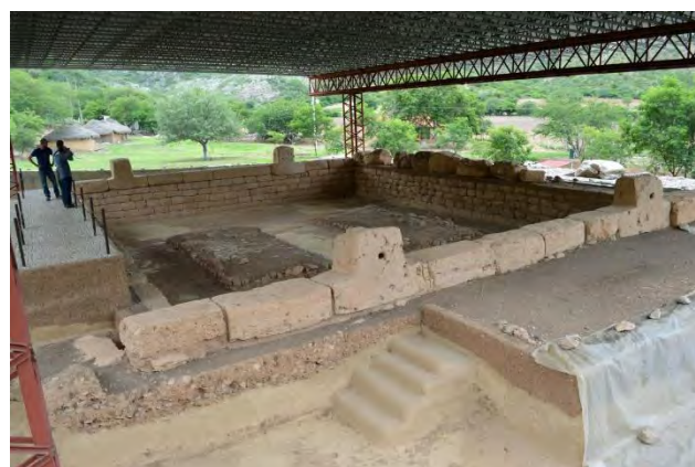
Figura 8.23. Patio hundido de Teopantecuanitlán. Foto del autor.
