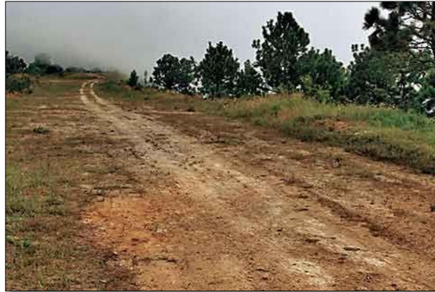
Figura 3.6 Camino de Terracería. Fuente: SCT, Subsecretaría de Infraestructura.
