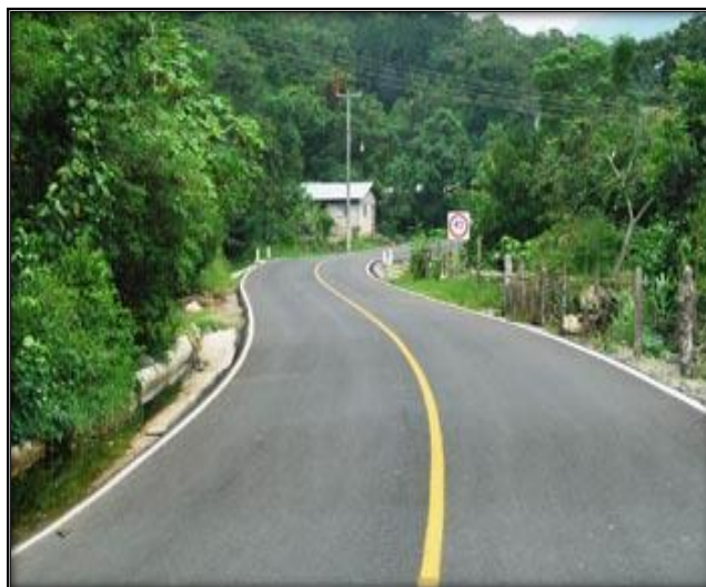
Figura 3.10 Carretera Alimentadora. Fuente: SCT, Subsecretaría de Infraestructura.
