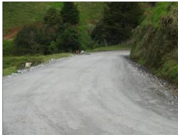
Figura 3.7 Camino Revestido. Fuente: SCT, Subsecretaría de Infraestructura.
