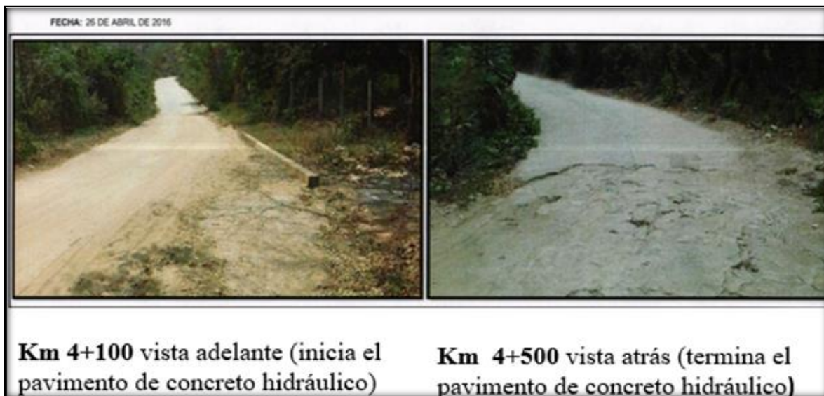
Figura 5.3 Anexo fotográfico del proyecto relacionado al ramo 23: " Construcción de caminos de acceso. Col. Lomas del Aire". Fuente: Información del centro SCT Guerrero.
