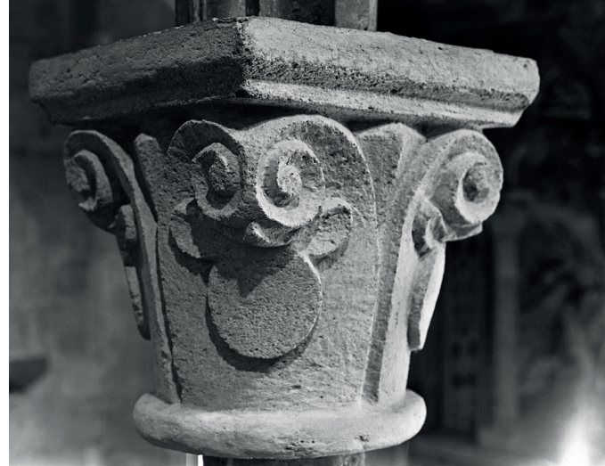
Detalle de columna, ejemplo de la arquitectura del Centro Cultural.
