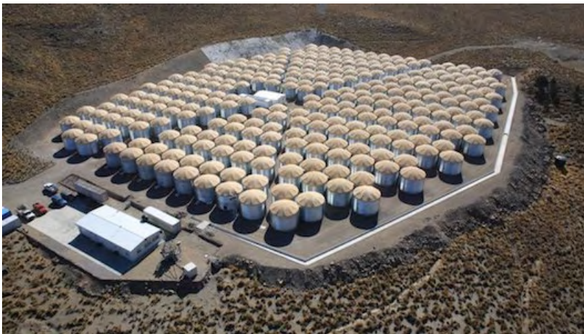
Figura 1: Fotografía aérea los 300 tanques que conforman al observatorio HAWC, en el centro se encuentra el cuarto de control. Imagen tomada de HAWC
