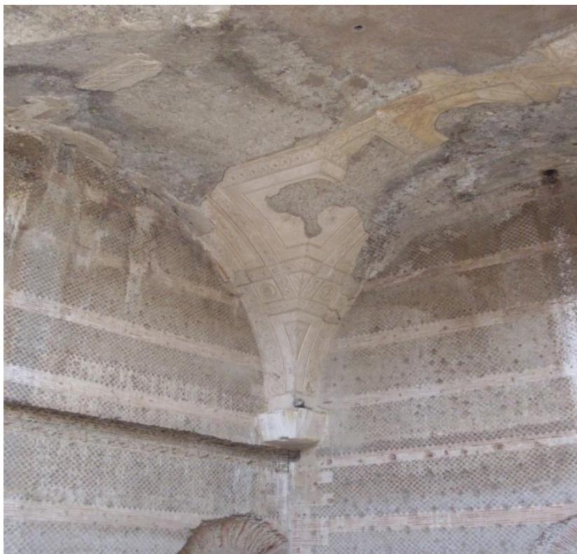
**Ilustración 8 Recubrimiento en construcción a base de cal.**
