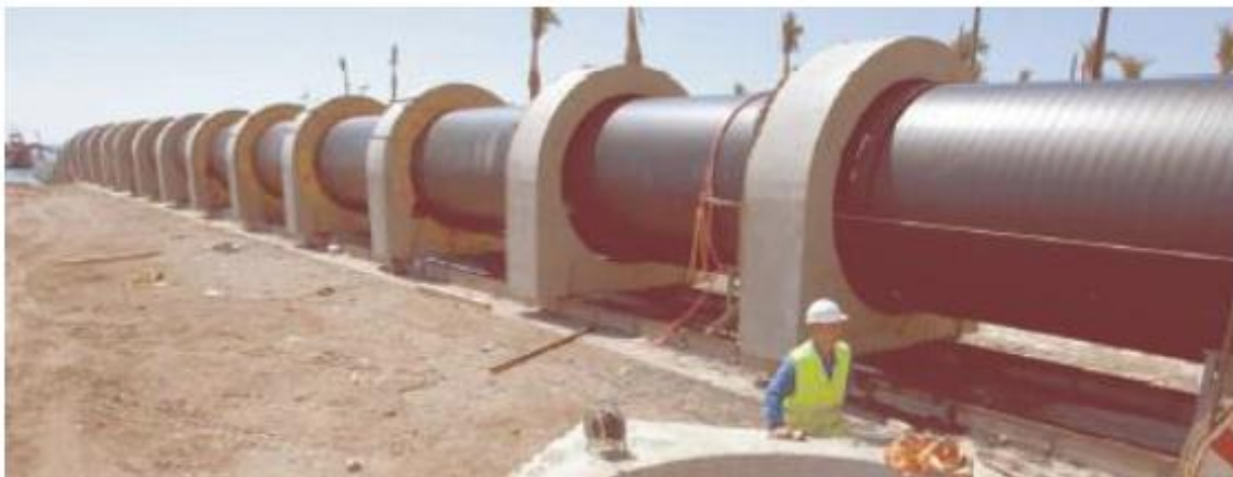
Imagen 60 Ejemplo de inmisario submarino. Fuente: Lezáun, A.M. (1 Octubre 2014), Diseño de una planta desaladora en el municipio de Telde (Canarias) Recuperado de: academica-e.unavarra.es/bitstream/2454/15397/1/629249.pdf
