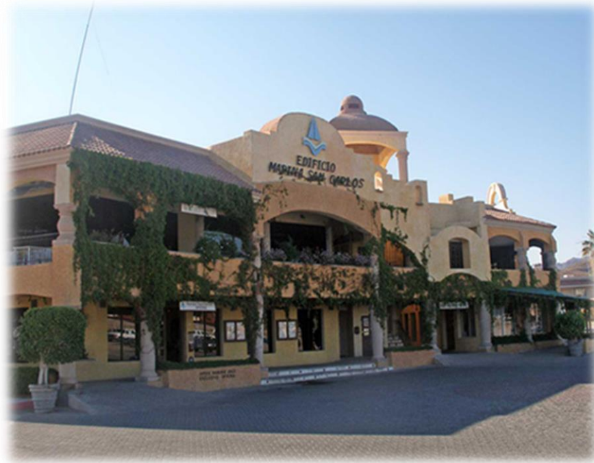
Imagen 10 Edificio principal de la Marina de San Carlos
