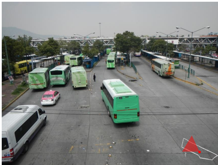
Figura 4. Vista al noroeste desde el predio
