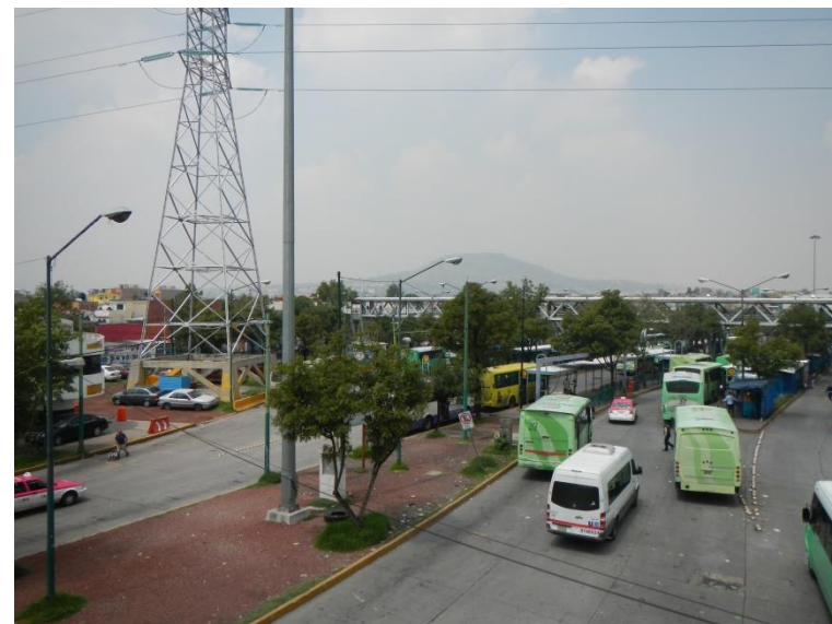
Figura 2. Torres de alta tensión dentro del predio
