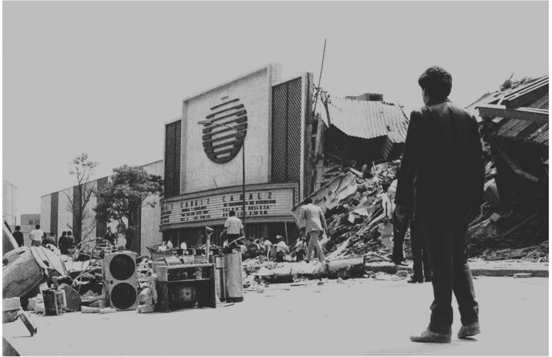
Imagen 59.- Eloy Valtierra. s/t. Aquella mañana que cambió la configuración de la ciudad. Las instalaciones de la empresa Televisa se vinieron abajo. Ciudad de México, 1985.
