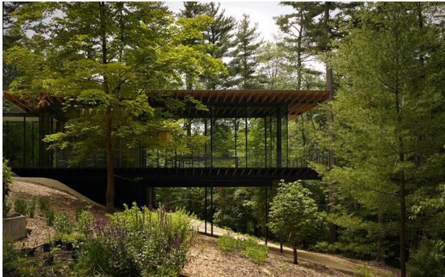
Imagen 18. Glass House del Arquitecto Kengo Kuma. Connecticut, E.U.A. En http://kkaa.co.jp/works/architecture/glass-wood-house/
