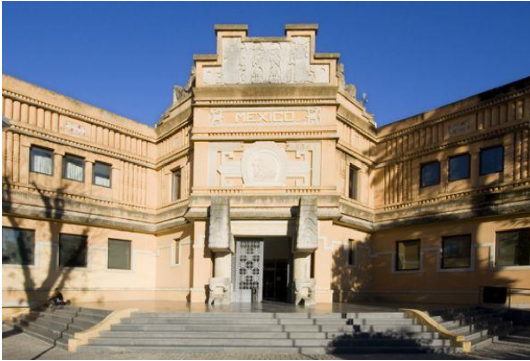
Imagen 5. Pabellón México (1929) del Arquitecto Manuel Amabilis.
