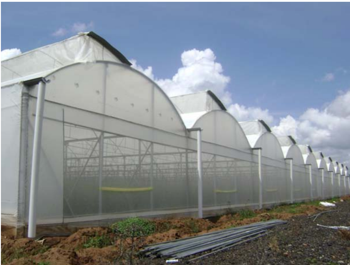
Invernaderos tipo capilla de la Constructora De Invernaderos Y Materiales Agrícolas S.A. De C.V. Zamora
