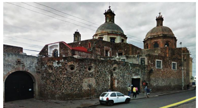
3. Fachada a base de muros macizos mampostería
