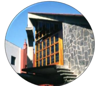
4. Escalera de concreto
