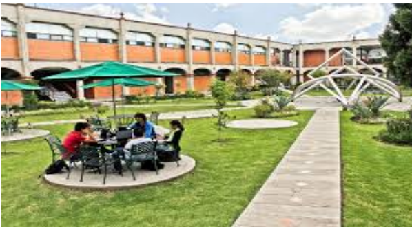
Pasillo exterior (Aulas)
