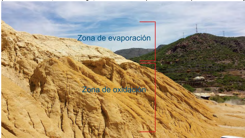
Figura 3.2 Zonas determinadas en la Presa de Jales I. La zona de evaporación y la zona de oxidación.
