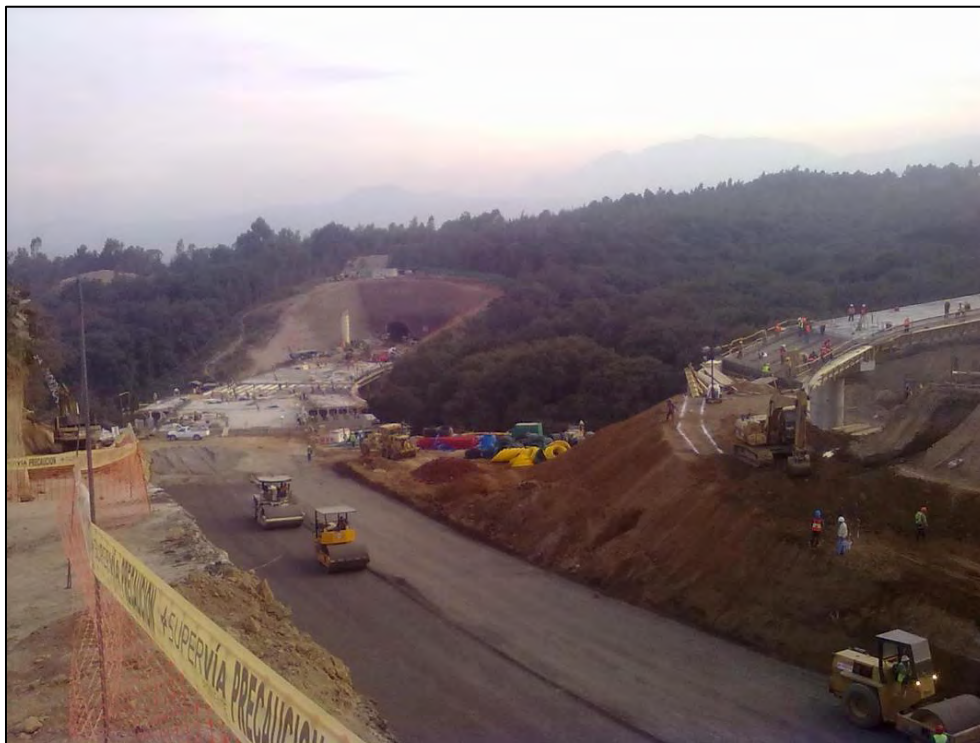
Figura 5. Construcción de Terracerías en Túnel 2 y Puente 3.
