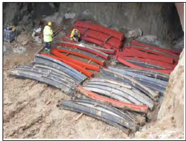
Figura 16. Marcos metálicos: Esquema y recepción en obra de piezas.
