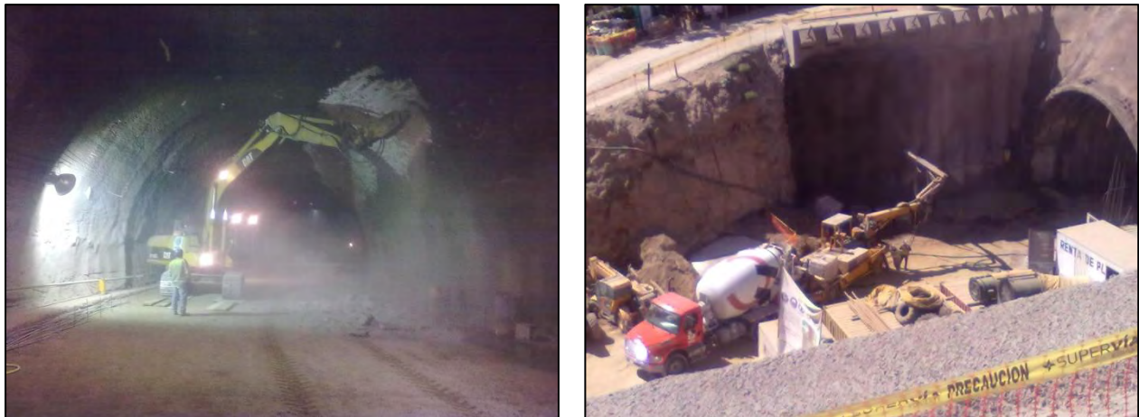
Figura 20. Proceso constructivo en Túnel 2.
