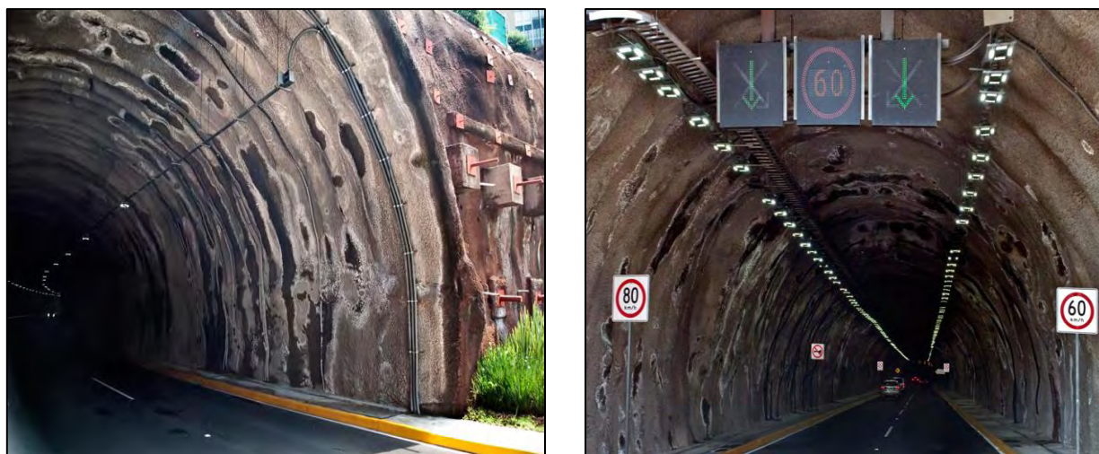
Figura 18. Colocación de arañas, geomembrana y aplicación de concreto lanzado.
