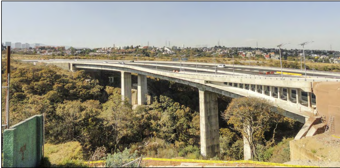
Figura 26. Obra civil concluida en Puesto 1.
