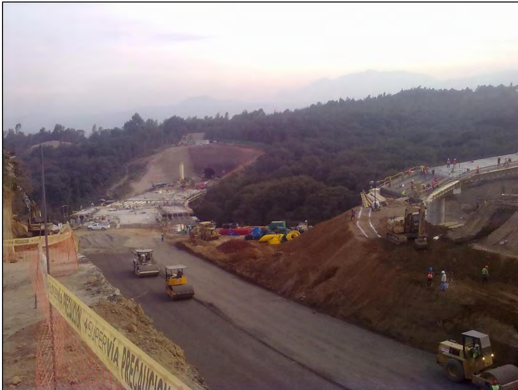
Figura 30. Obra civil en Puente 3. Fuente: Elaboración propia, 2012.
