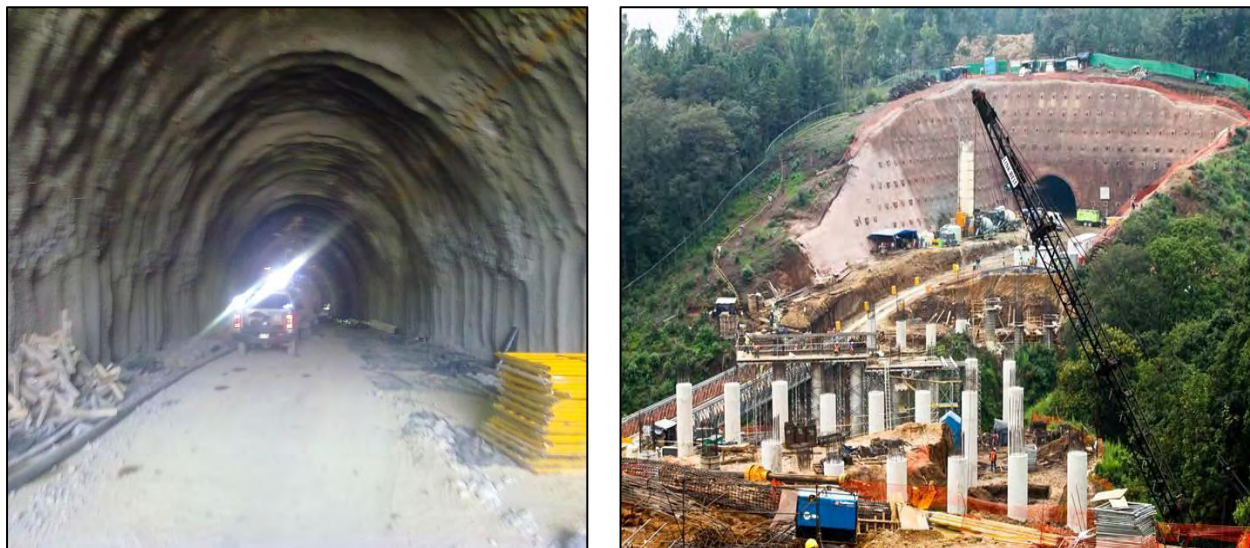
Figura 23. Construcción del Túnel 5.
