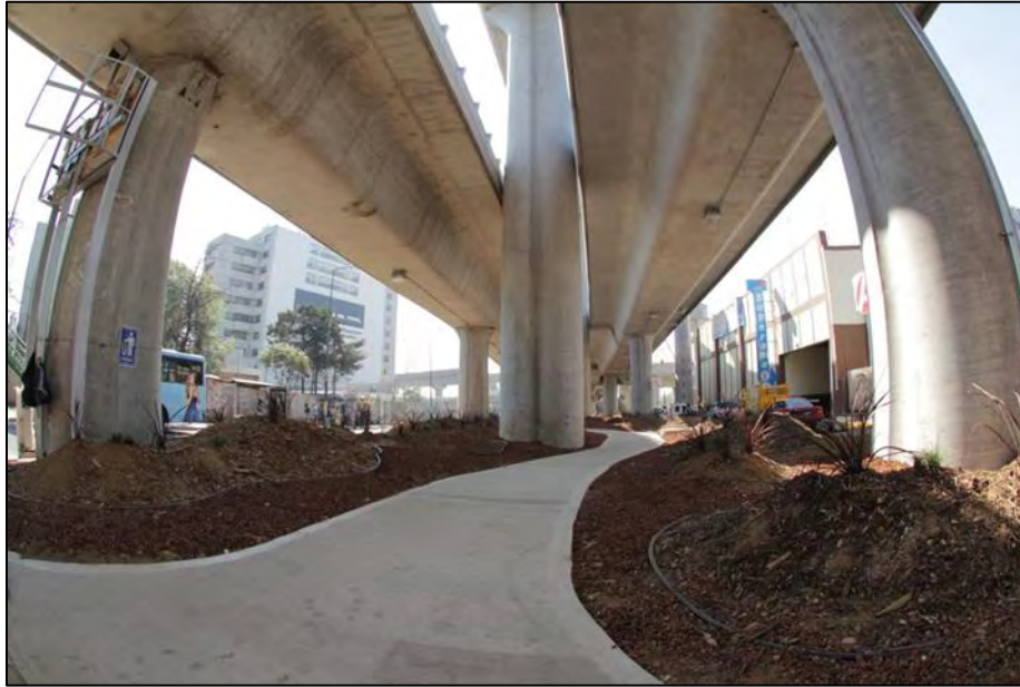
Figura 32. Puente Luis Cabrera - Magnolia.
