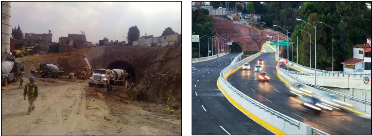
Figura 21. Construcción y funcionamiento de Túnel 3.
