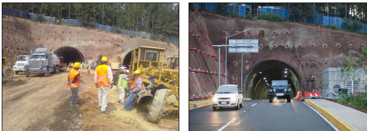
Figura 22. Construcción y funcionamiento de Túnel 4.
