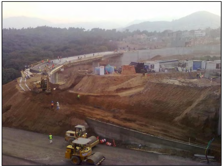
Figura 29. Obra civil en Puente 2. Fuente: Elaboración propia, 2012.
