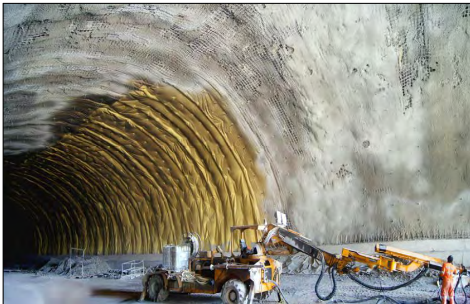
Figura 17. Colocación de arañas, geomembrana y aplicación de concreto lanzado.
