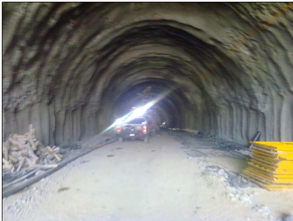
Figura 6. Concreto lanzado en Pilas y Túneles.
