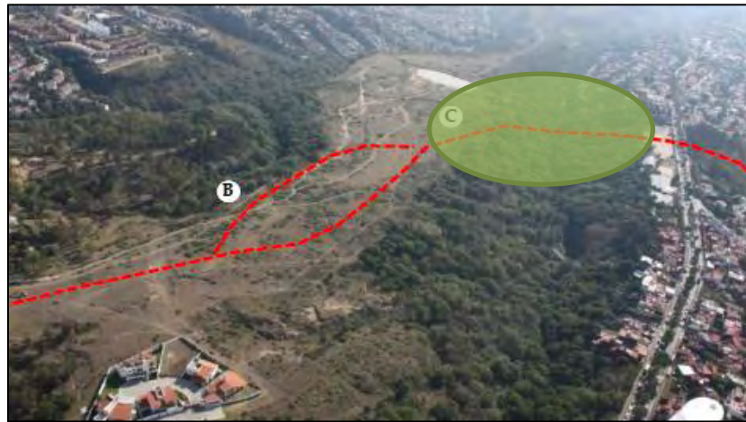
Figura 25. Zona de proyecto Puente 1.
