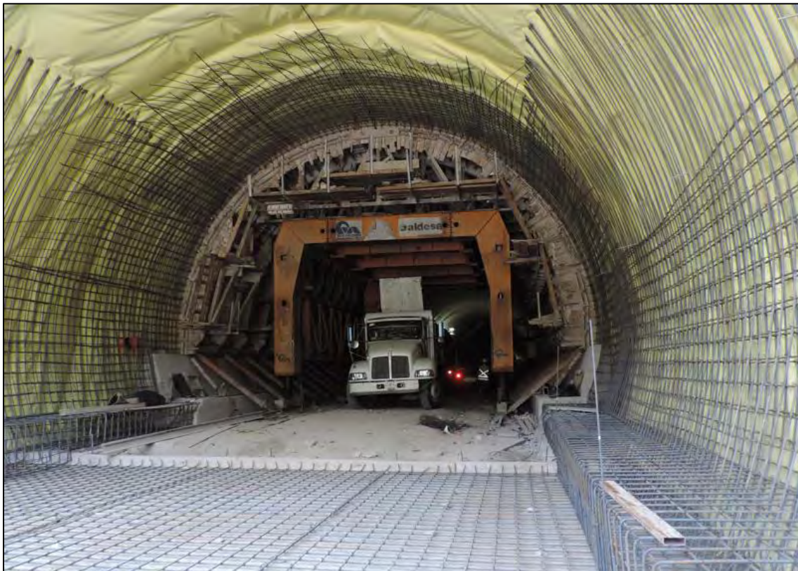
Figura 7. Elementos de acero en Túneles.
