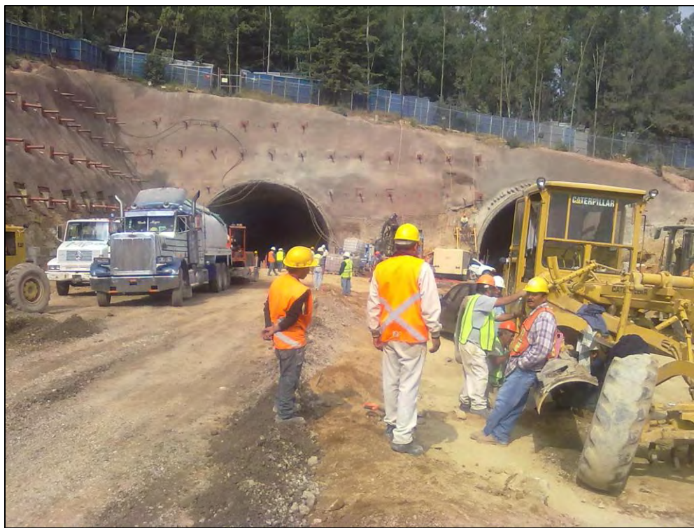
Figura 4. Recepción de materiales para terracerías en Túnel 1 “Desierto de los Leones”.
