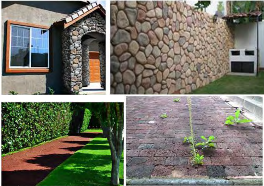
Figura A.2.1. Usos constructivos y ornamentales de la piedra de río (parte superior de la figura) y el tezontle (parte inferior de la figura) en México (Fotos de esta investigación)
