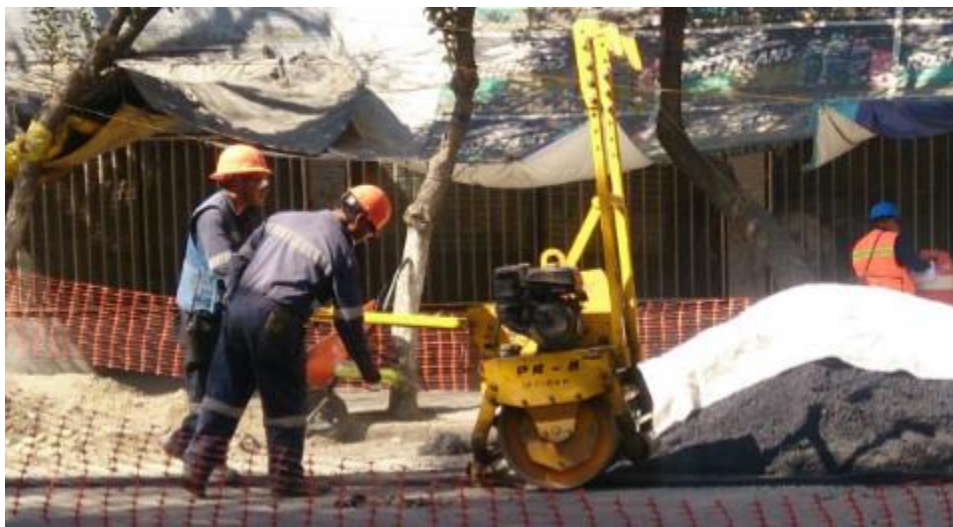
Figura 14. Compactación por medio de rodillo mecánico.
