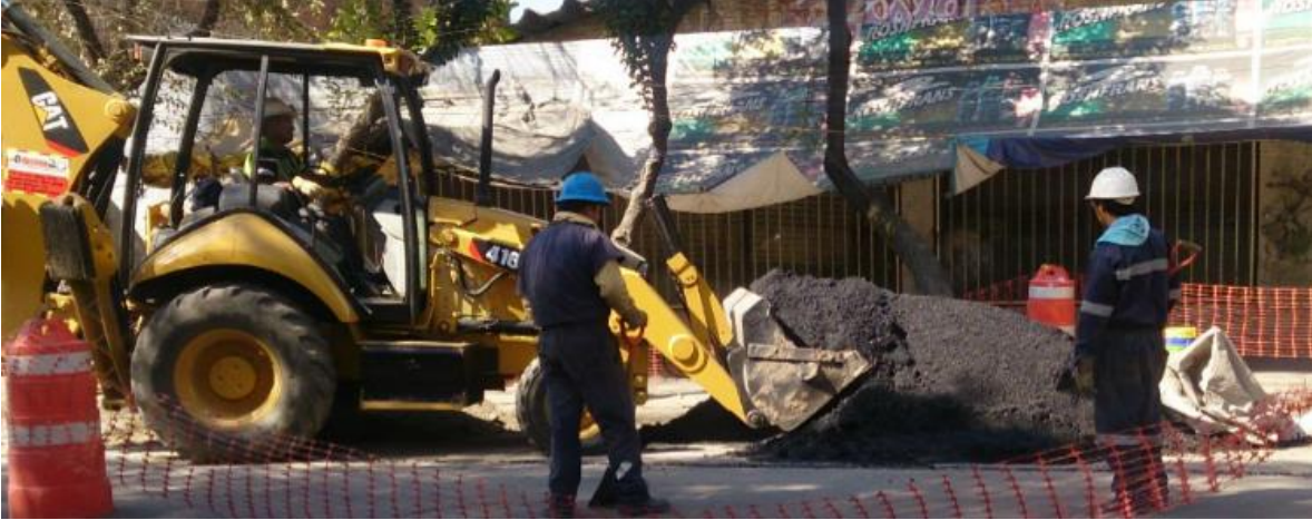
Figura 12. Almacenamiento de la mezcla asfáltica en caliente.
