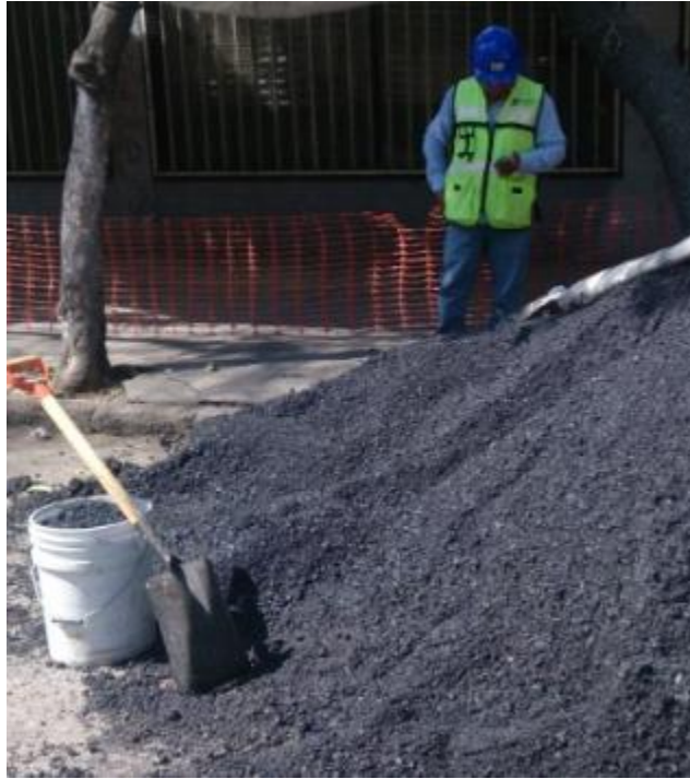
Figura 15. Medición de la temperatura de la mezcla asfáltica y muestreo de la misma.
