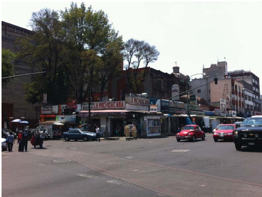
ESTADO ACTUAL DEL CONVENTO, 2014.
