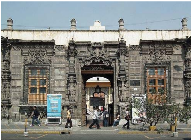
CASA DE LOS MASCARONES (ESTADO ACTUAL) 2014
