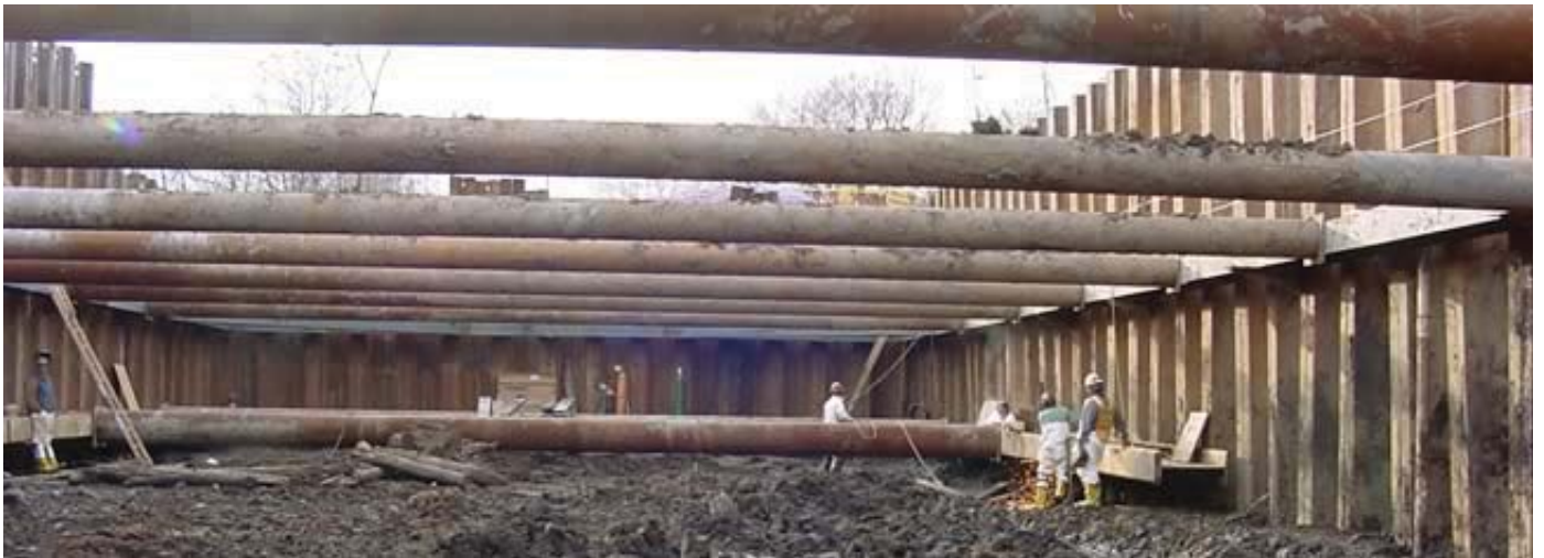
Terreno excavado contenido por Muro Berlín
