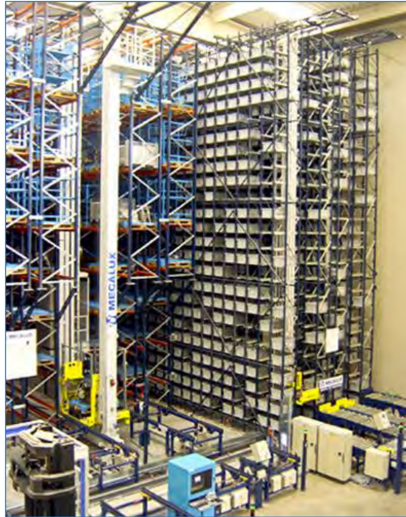
Figura 6.13 Zona de Racks
