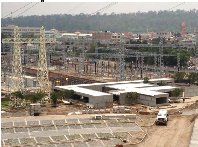
Imagen 12. Proceso constructivo CFE-auto
