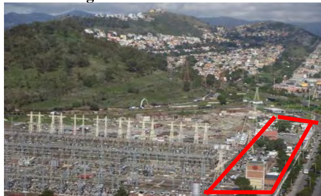
Imagen 4. Áreas de demolición.
