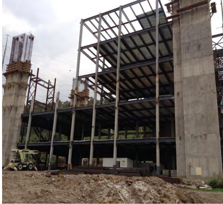
Imagen 5. Proceso constructivo del Centro de Operación Logística.
