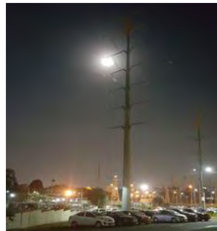
Imagen 1 y 2. Postes metálicos. Truncocónicos para la elevación de líneas de transmisión
