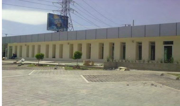
Imagen 14. Proceso constructivo Centro de Distribución
