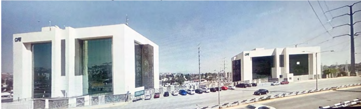
Imagen 15. Conjunto Los Remedios CFE.
