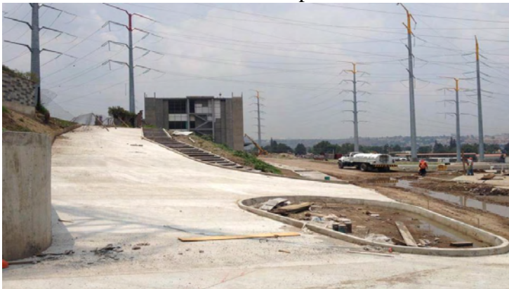
Imagen 1 y 2. Postes metálicos. Truncocónicos para la elevación de líneas de transmisión
