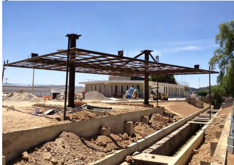
Imagen 11. Proceso constructivo Centro de Atención a Clientes
