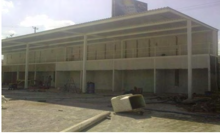
Imagen 13. Proceso constructivo Centro de Distribución
