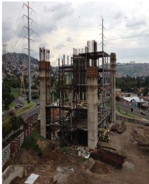
Imagen 6. Proceso constructivo del Centro de Operación Logística.
