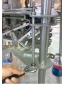
Figura 6.28: Instalación de guías laterales entre placa de tubos y placa de pesas. (Cortesía de [22])
