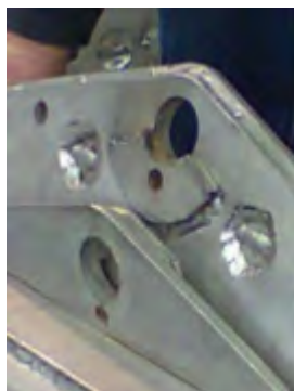
Figura 6.7: Detalle del ensamble de la orejas de los marcos. (Cortesía de [22])
