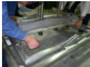
Figura 6.9: Descenso y colocación de la placa superior con yugo sobre el marco auxiliar.
