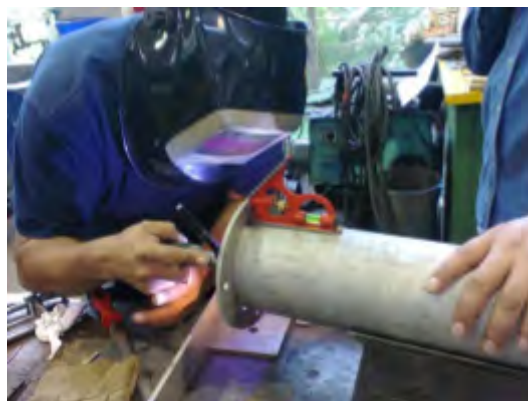
Figura 5.56: Escuadre y soldadura de la brida abierta al tubo. (Cortesía de [23])
