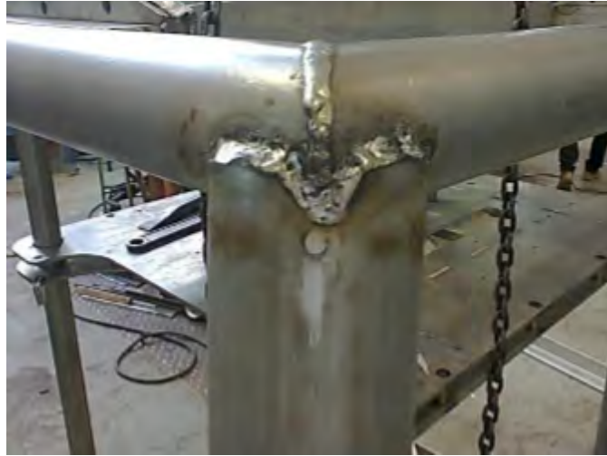
Figura 5.100: Detalle de la soldadura de los toldos al marco exterior.
