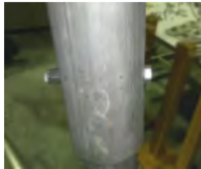
Figura 6.15: Ensamble de las patas con los toldos por medio de tornillo y tuerca. (Cortesía de [22])
