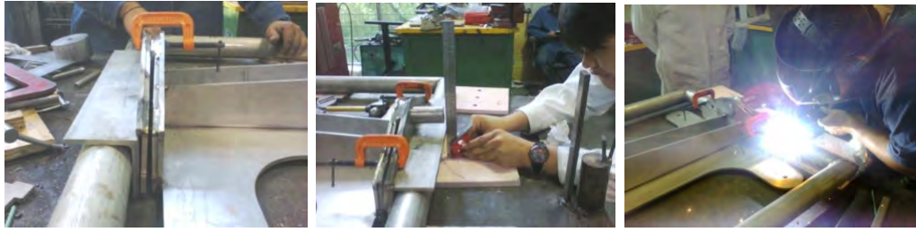
(a) Soldadura de soporte superior. (b) Alineación del soporte. (c) Soldadura del soporte y el marco.
