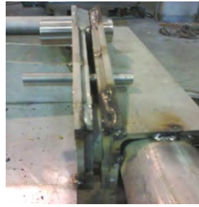
(d) Detalle de la soldadura.
