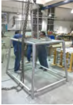
Figura 6.17: Estructura exterior ensamblada.
