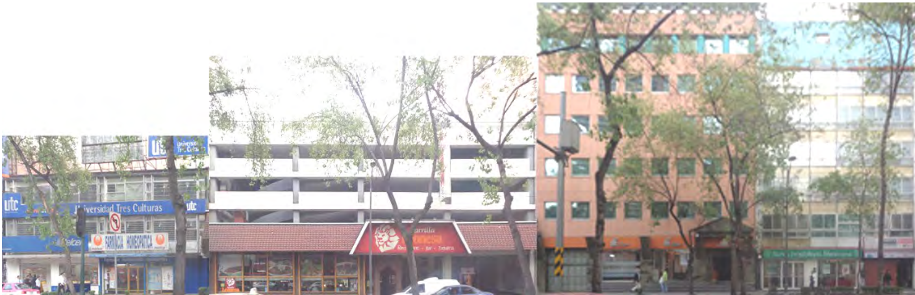
Imagen 8. Fachadas colindantes Av. Insurgentes
