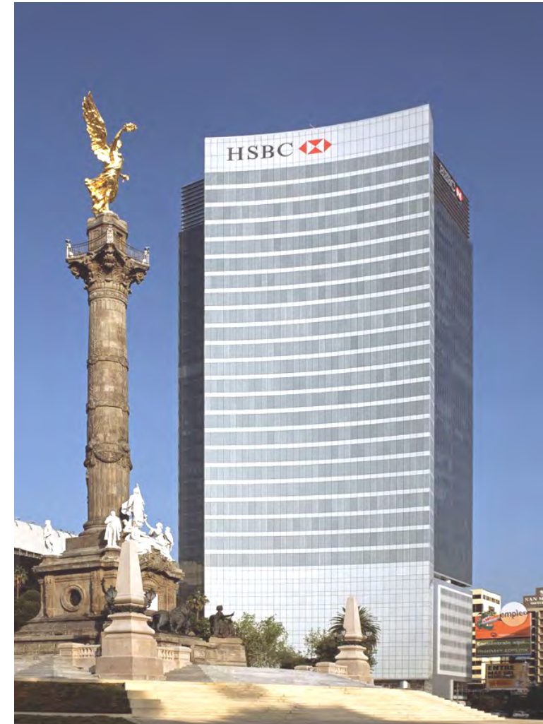
Imagen 2. Torre HSBC Paseo de la Reforma, Ciudad de México.
