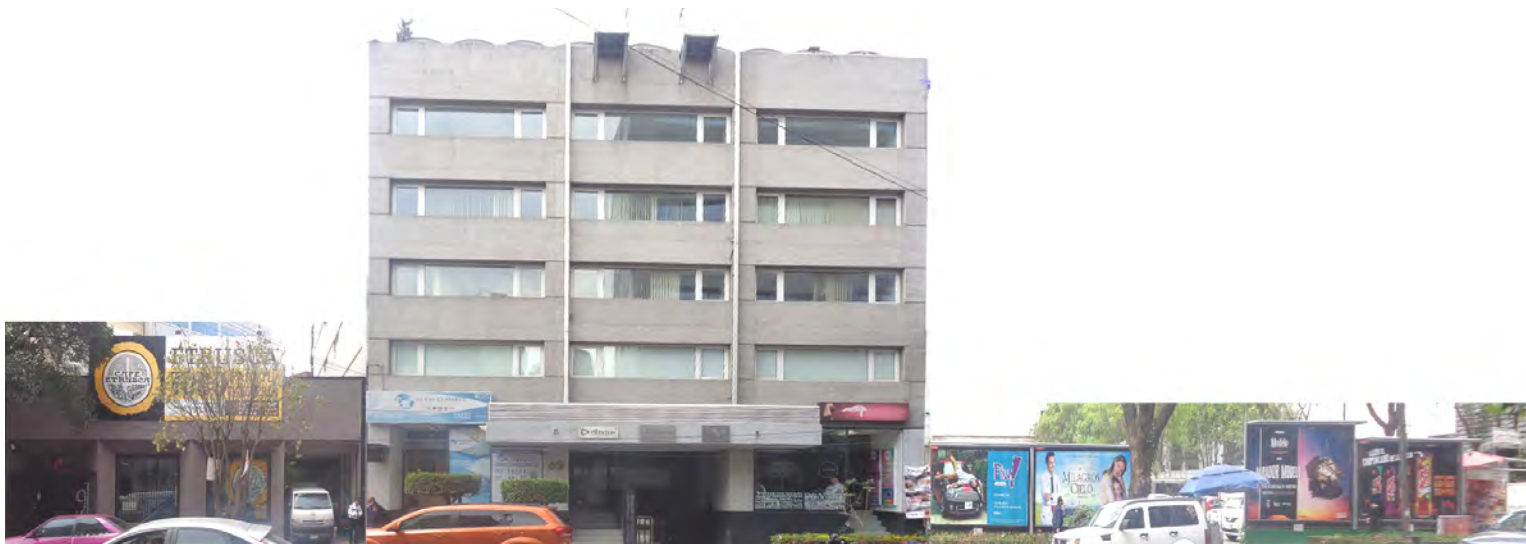
Imagen 9. Fachadas colindantes calle Liverpool
