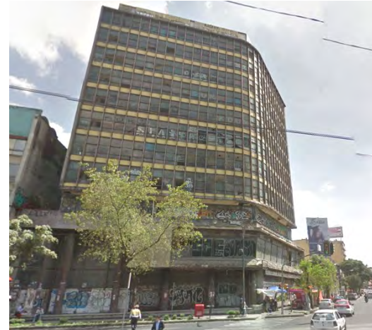
Imagen 7. Edificio Seguros Azteca estado actual
