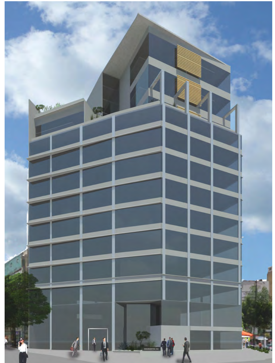
Imagen 20. Vista del edificio desde Av. Insurgentes esquina con Niza
