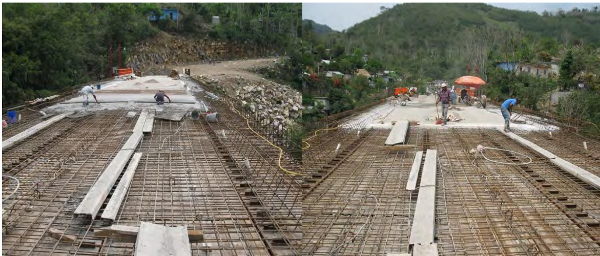
Figura 5.52 Armado de losa y banquetas listo para realizar el colado, asimismo se pueden visualizar los conectores a cortante y los drenes de pvc (ambos extremos de la losa central).
