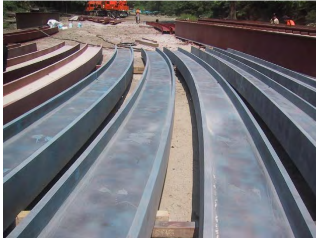
Figura 5.41 Dovelas del arco en sitio.
