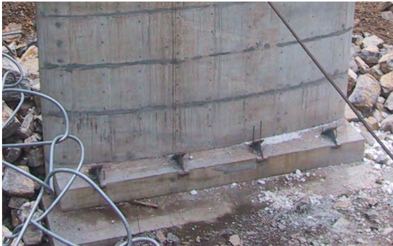
Figura 5.43 Arranque del arco, empotrado a la estructura de concreto (pila No. 2).
