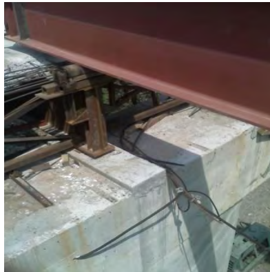
Figura 5.35 Rodillo que permitió el avance de las traveses sin que se lastimaran los elementos.
