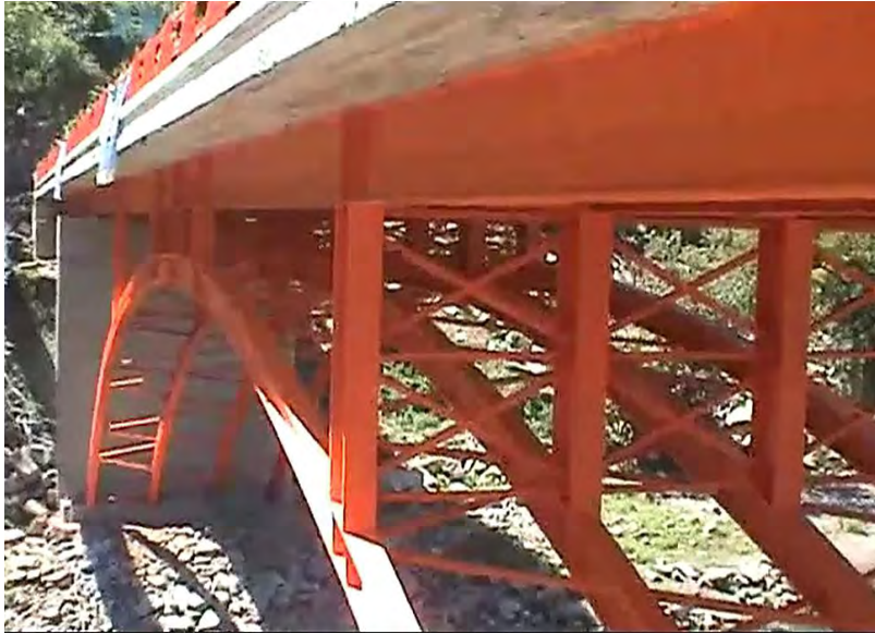
Figura 5.51 Contraventeo vertical en los atizadores del arco una vez terminado el puente.
