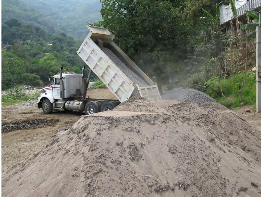
Figura 5.9 Camión de volteo trayendo los agregados pétreos del banco de materiales.
