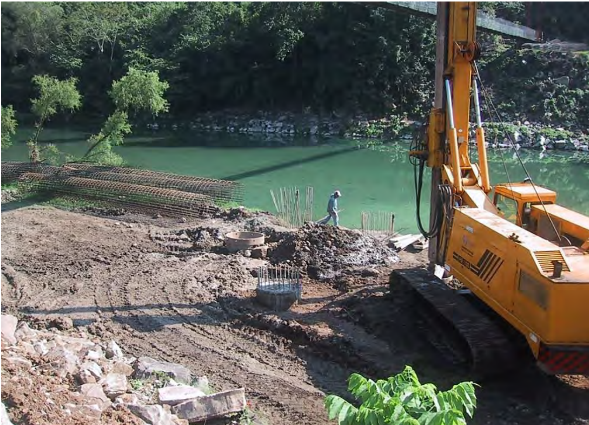
Figura 5.4 Construcción de pilas coladas en sitio.
