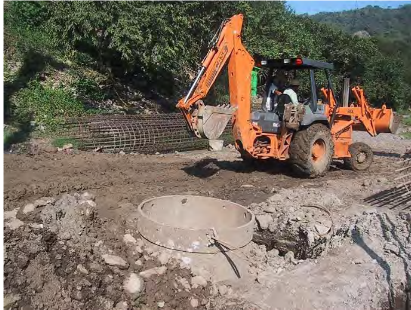
Figura 5.5 Retroexcavadora con cargador frontal.
