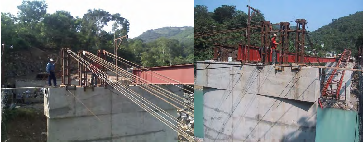
Figura 5.32 Sistema de poleas diseñado con un menor peso para que fuera factible cargarlas (vista frontal y posterior).
