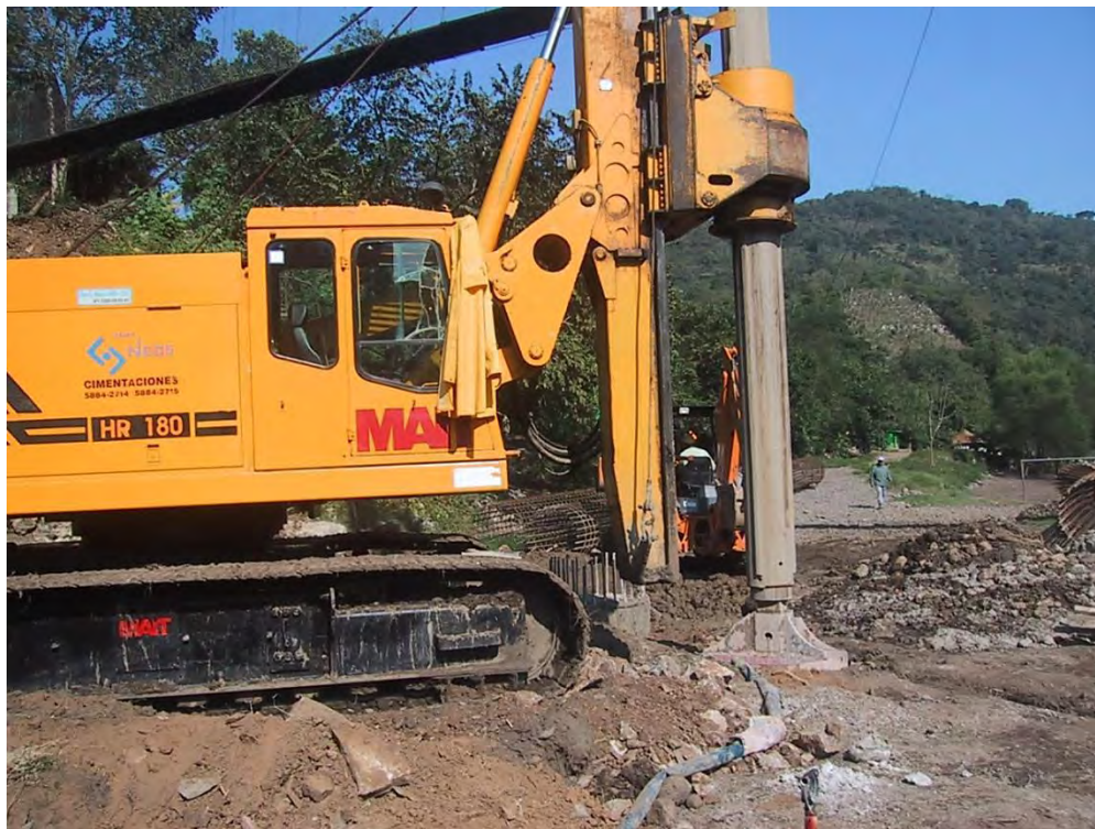
Figura 5.3 Inserción de ademe metálico recuperable.
