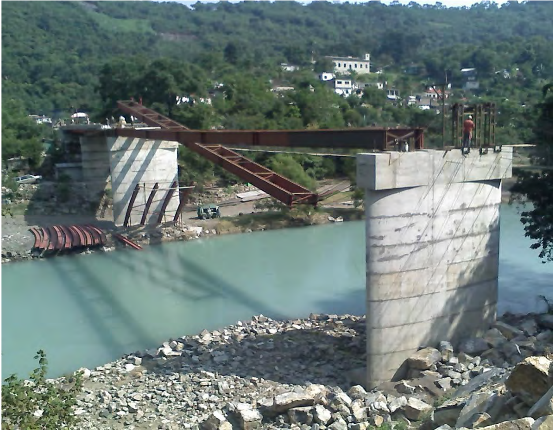
Figura 5.36 Montaje de las traves centrales visto desde otro ángulo.
