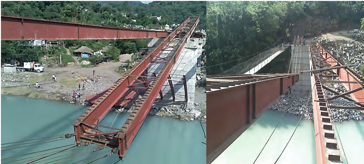
Figura 5.31 Lanzado del segundo par de traveses centrales.
