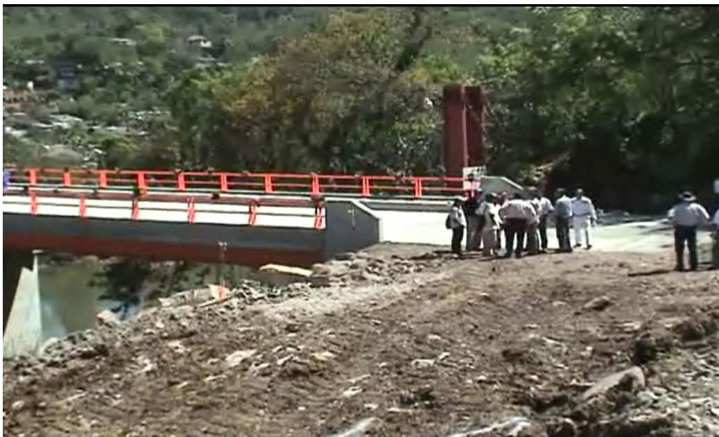
Figura 5.62 Salida del puente (margen izquierda) donde se observan el camino de terracería existente y el aproche construido siguiendo el alineamiento horizontal del puente.
