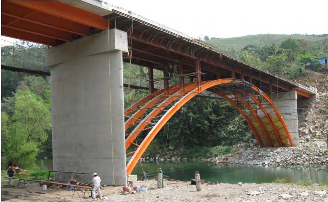
Figura 5.49 Cimbra de madera en el tramo central del puente lista para construir la losa de concreto.
