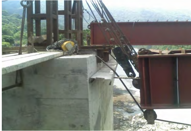
Figura 5.38 Par de travesaños llegando al punto de apoyo de la pila No. 2, se observan los cables guía debajo de las mismas.
