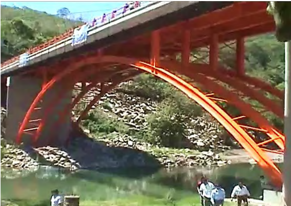
Figura 5.60 Arco del puente una vez terminado.
