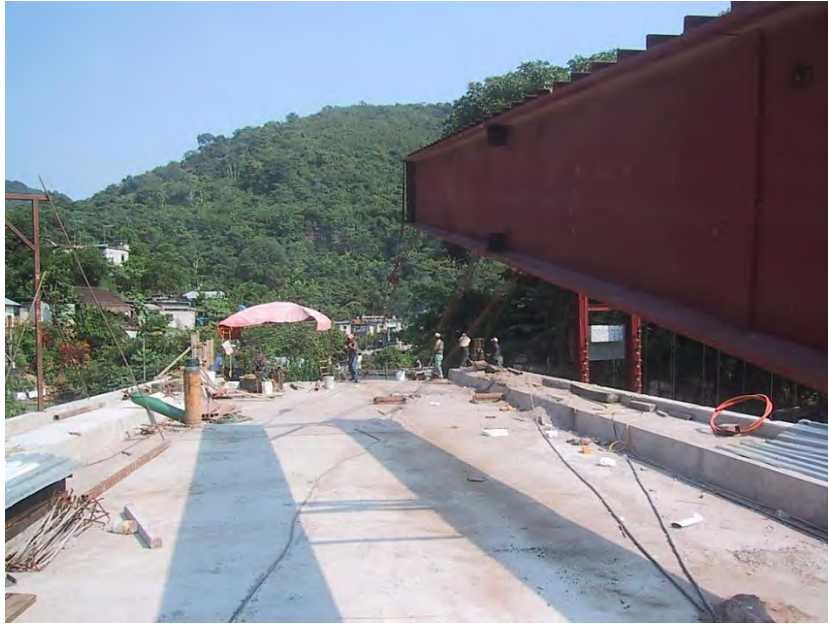
Figura 5.34 El par de traveses estaba sujetado también en el otro extremo.
