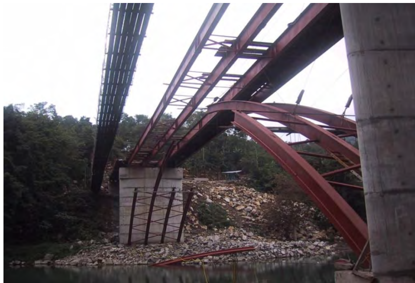
Figura 5.45 Montaje del segundo tramo del arco, se pueden observar los puntos a partir de los cuales se sujetaron las vigas del arco.
