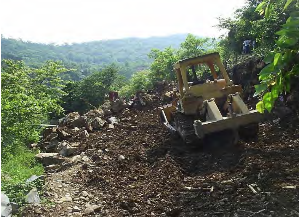
Figura 5.1 Tractor D-8 facilitando el acceso para la construcción del puente.
