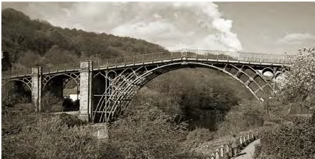
Figura 1.1 El Iron Bridge construido sobre el río Severn en Shropshire, Inglaterra. Fue el primer puente de estructura metálica construido en el mundo en 1779, aún está en uso.
