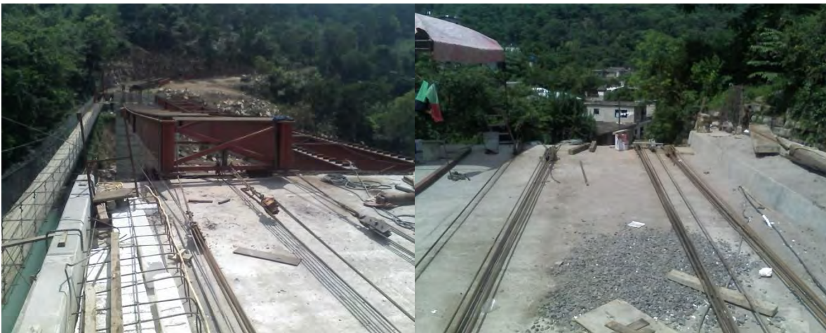
Figura 5.37 Montaje en su etapa final (visto desde la parte posterior).
