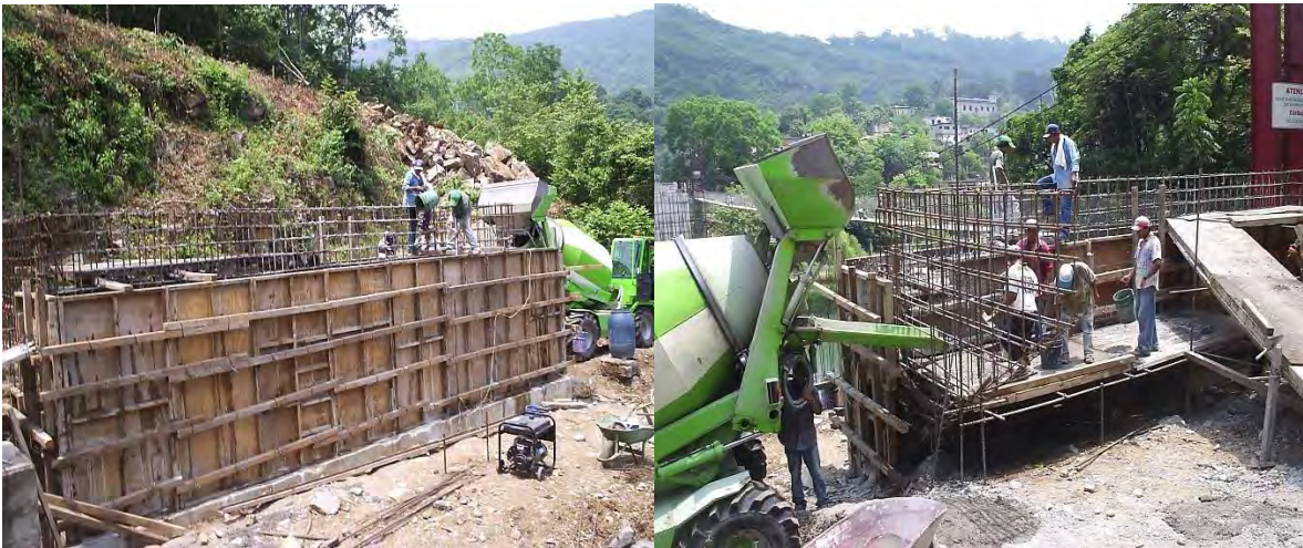
Figura 5.12 Colado del caballete No. 1.
