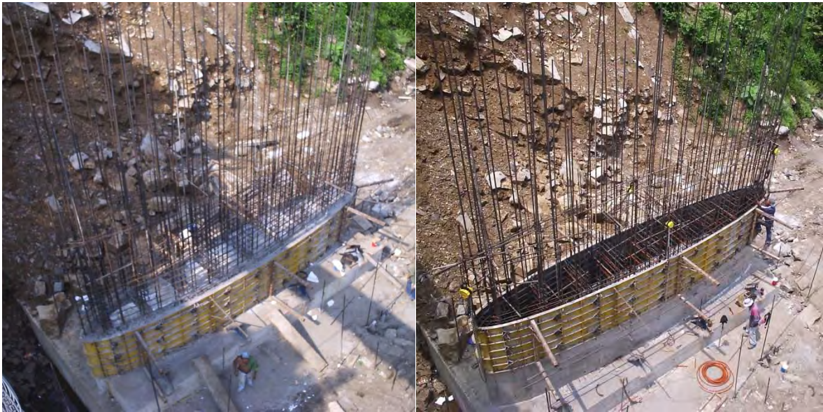
Figura 5.18 Procedimiento constructivo de las pilas (pila No. 2).
