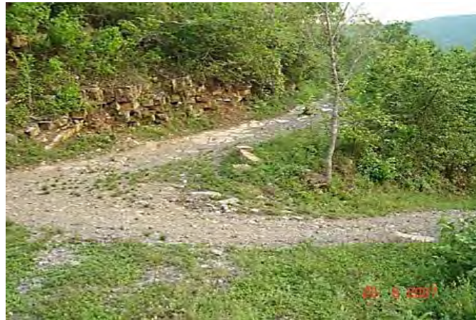
Figura 3.3 Condiciones tanto físicas como bióticas en la salida del puente previo a su construcción, en donde puede observarse que sus elementos habían sido modificados con anterioridad por la construcción del camino existente.
