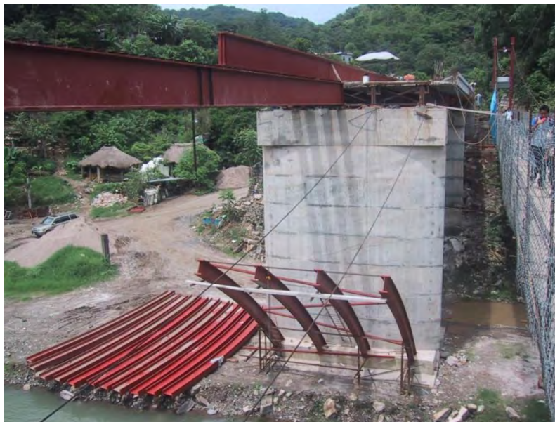
Figura 5.44 Primeras dovelas montadas (pila No. 3).
