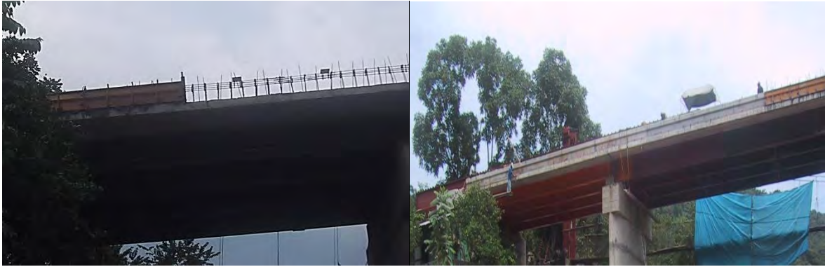
Figura 5.54 Construcción de la guarnición.
