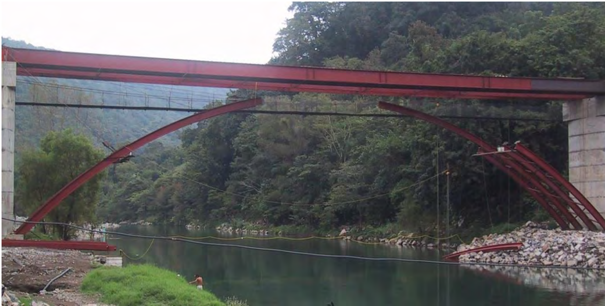
Figura 5.46 Procedimiento constructivo del arco visto en toda su longitud.
