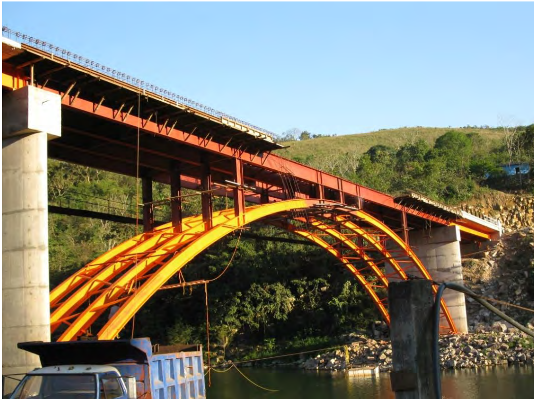
Figura 5.48 Ensamblado de atizadores del arco y colocación de cimbra de madera en el tramo central del puente.
